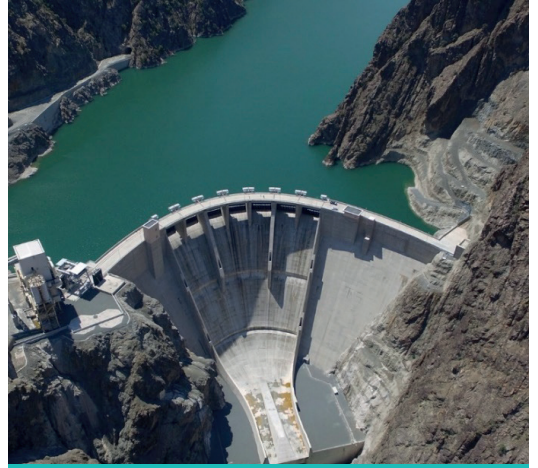
Artvin Barajı ve HES
