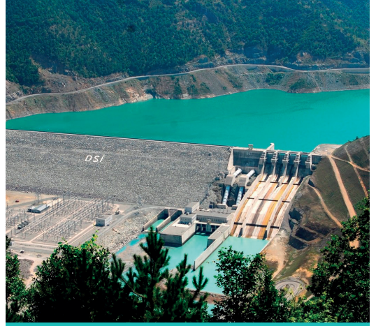
Borçka Barajı ve HES
