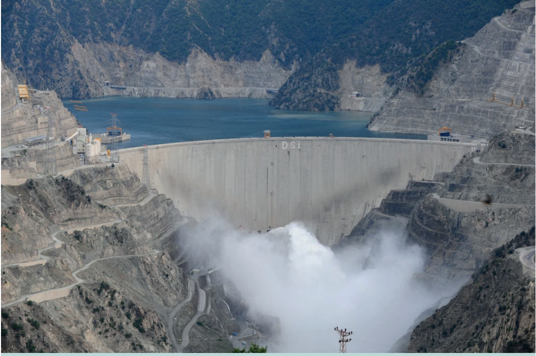
Şekil 3.7 Deriner Barajı ve HES
