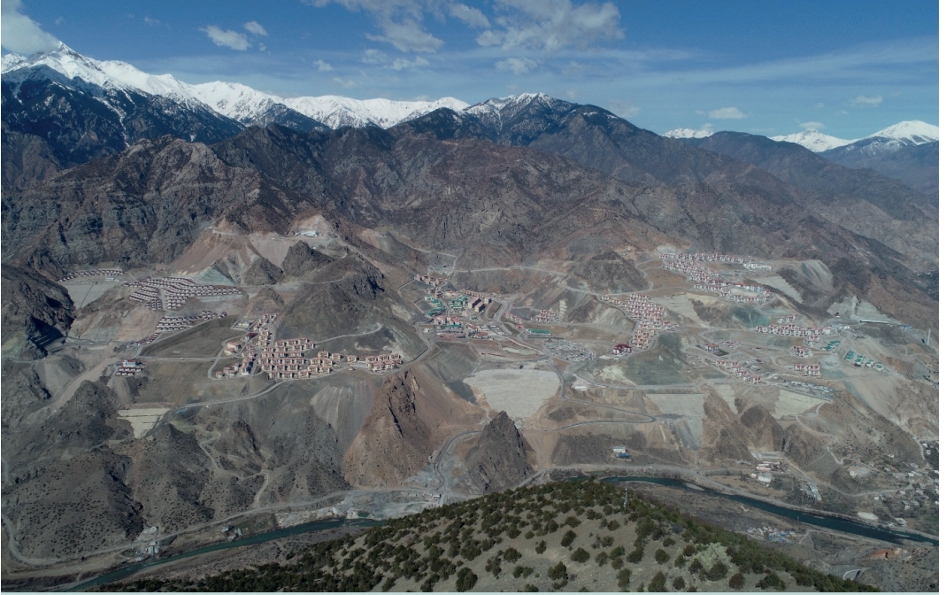
Şekil 3.29 Yusufeli Yeni Yerleşim Alanı Genel Görünüm
