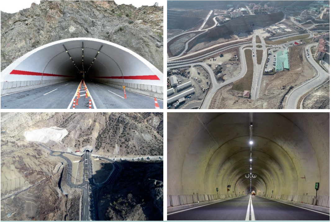
Şekil 3.36 Yusufeli’de İnşa Edilen Karayolu, Tünel ve Viyadükler
