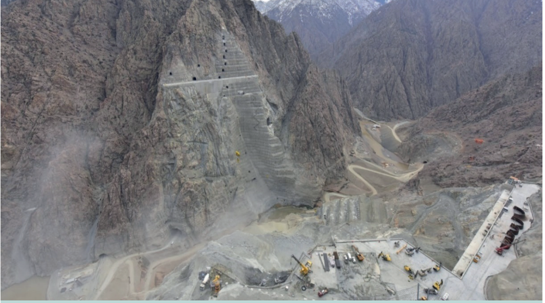
Şekil 3.22 Yusufeli Baraj İnşaatında Devam Eden Kazı İşlemleri (2 Mart 2017)
