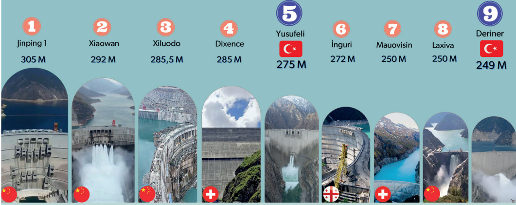
Şekil 3.18 Dünyanın 5. Yüksek Barajı Yusufeli Barajı
