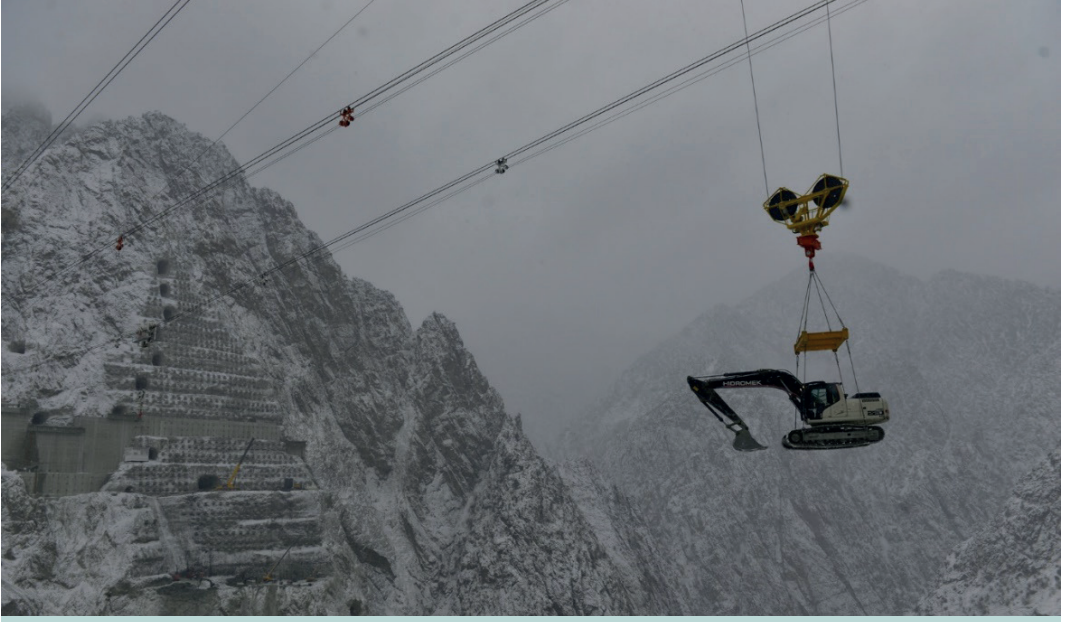
Şekil 3.20 Yusufeli Barajı İnşasında İş Makineleri Havada
