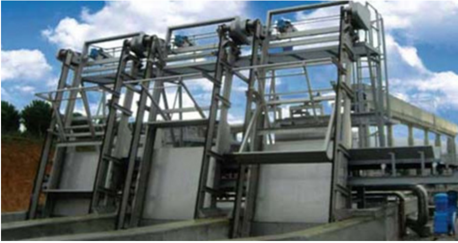
Şekil 7.17. Izgaralar, Izgara Presi ve Sürgülü Kapaklar
