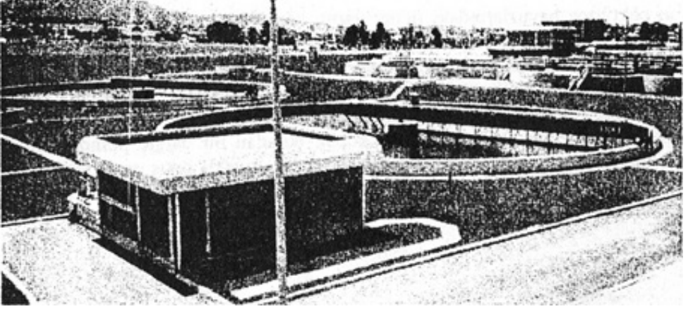
Şekil 7.26. Geri Devir Terfi Merkezi ve Çöktürme Havuzu
