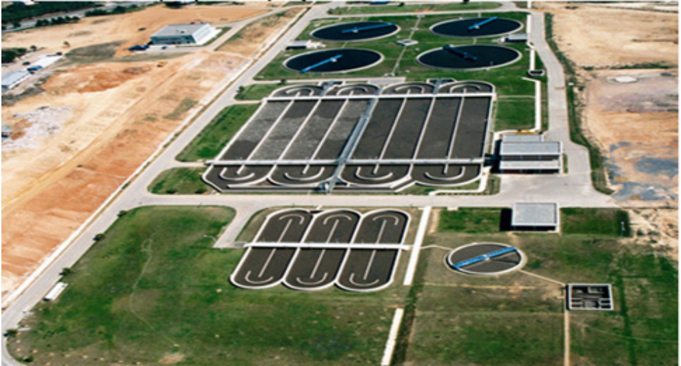
Şekil 7.13. Paşaköy İleri Biyolojik Arıtma Tesisini
