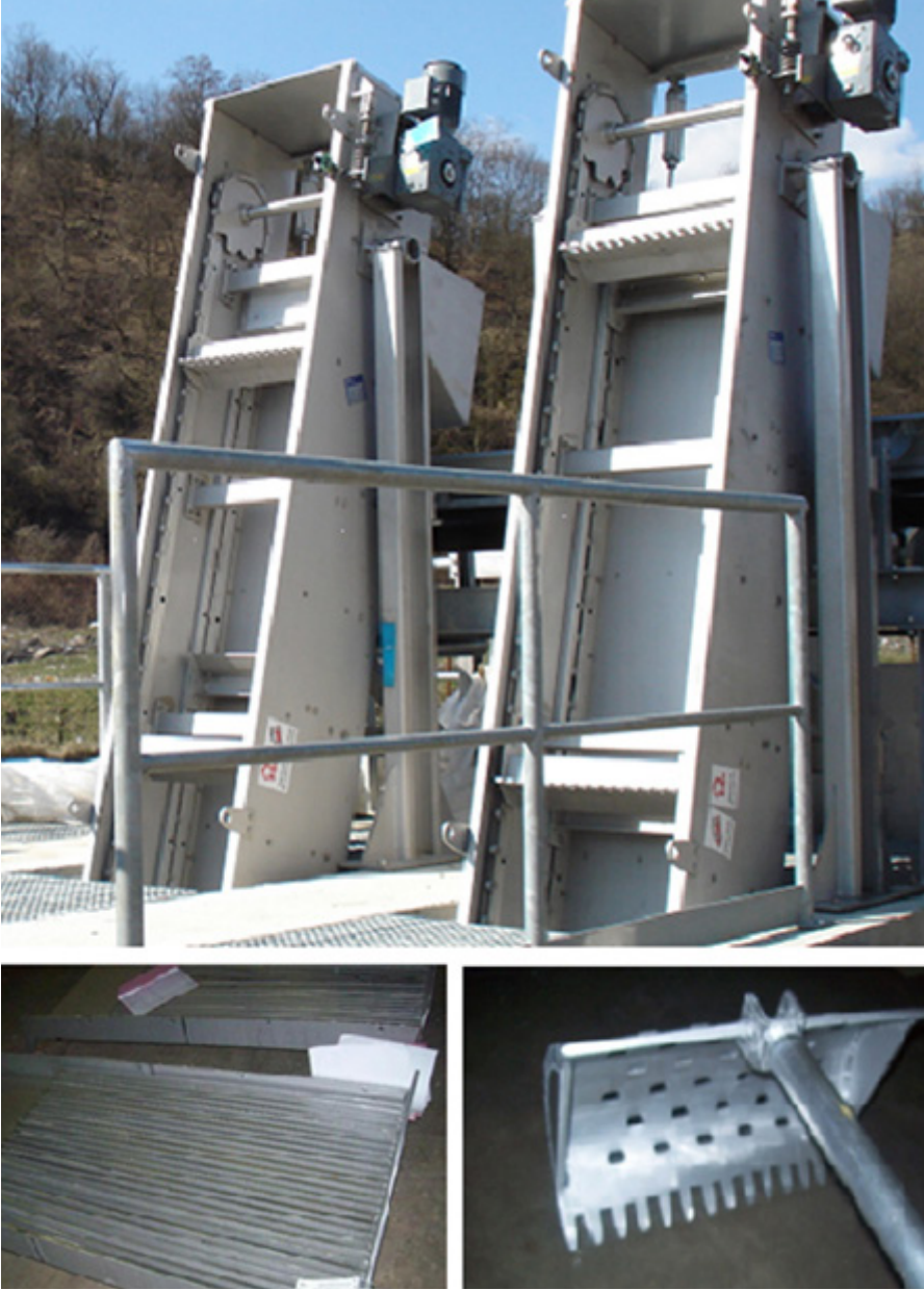
Şekil 3.6. Çubuk Izgara ve Temizleme Tertibatı
