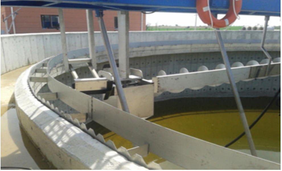
Şekil 7.25. Sıyrıcılar, Dalgıç Perde ve Savaklar
