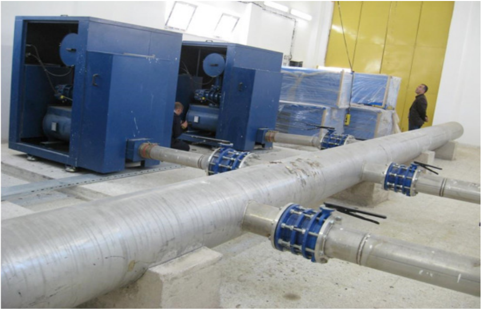
Şekil 7.19. Kum Tutucu Blowerları
