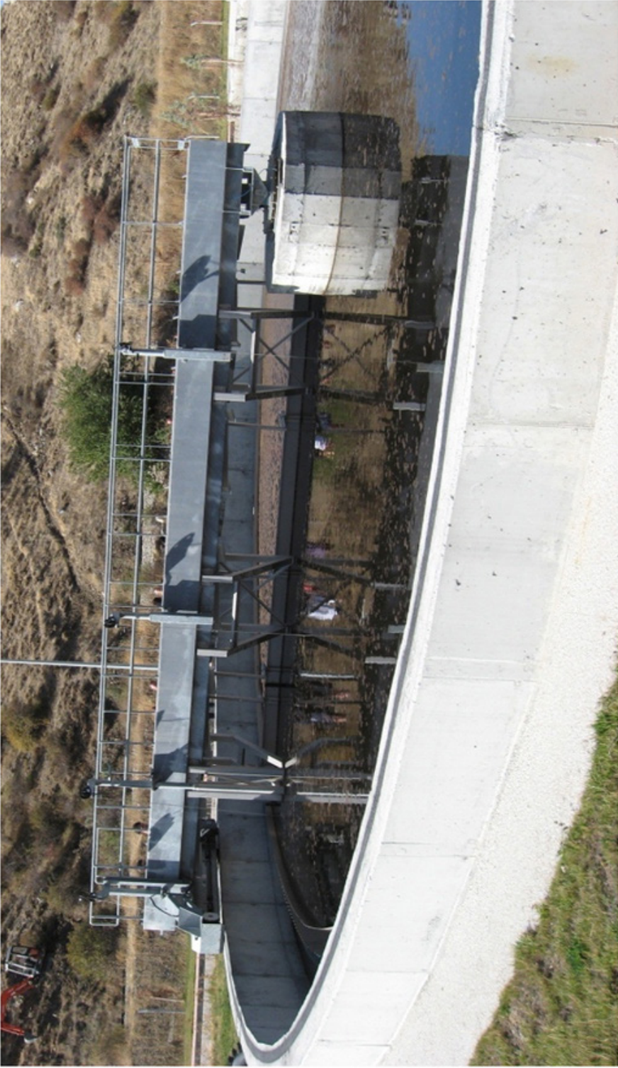
Şekil 5.8. Dairesel Çökeltim Havuzunun Çamur Sıyırma Tertibatı
