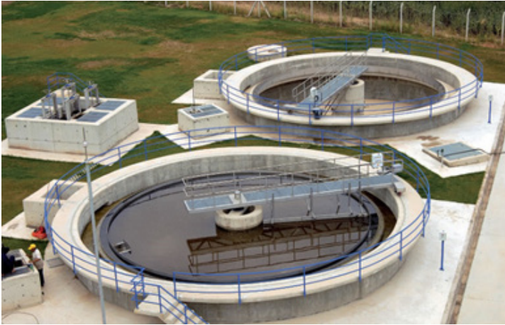
Şekil 7.24. Son Çöktürme Havuzları
