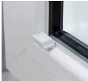
runde Glasleiste (Tiefe min. 9 mm)
