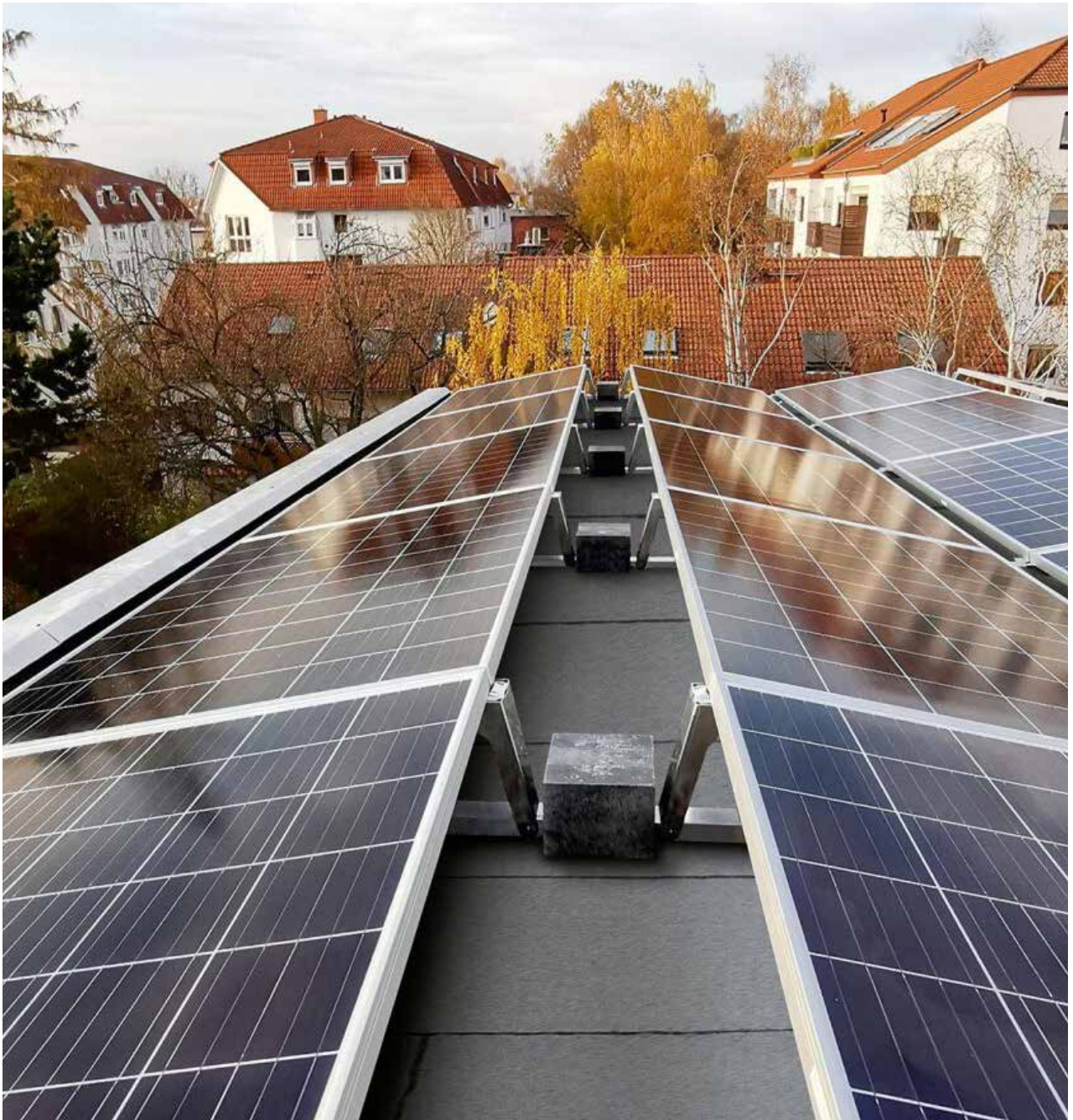
Schon die Dachdecke: PV easywave muss nicht verschraubt werden. Es ist ein aerodynamisches, durchdringungsfreies PV-System.
