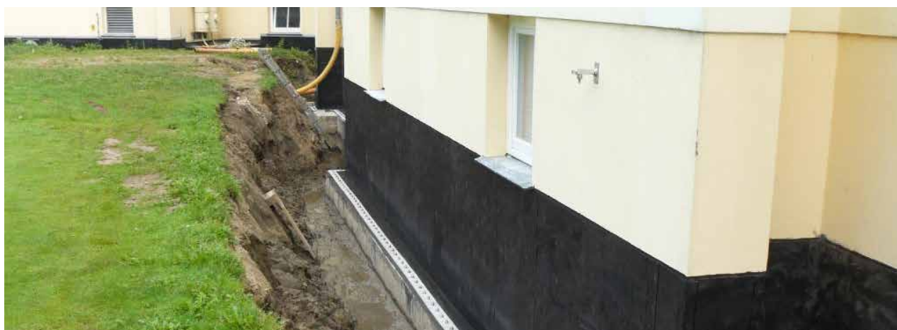
Bauwerksabdichtung in der Sanierung.
