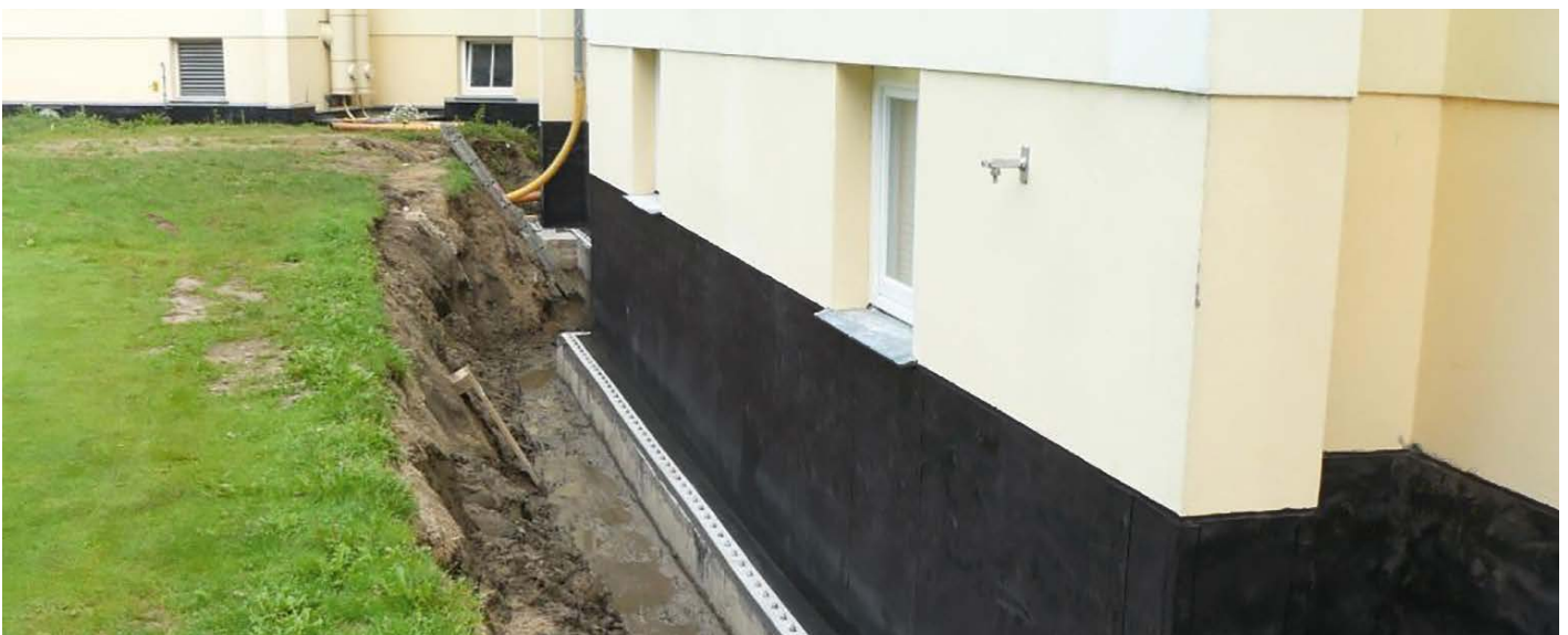
Bauwerksabdichtung in der Sanierung.
