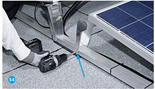
Schraube des Heckträgers lösen.
