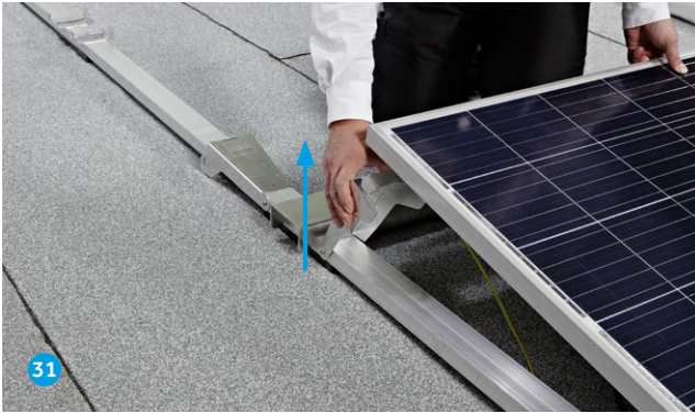
Äußeren Heckträger aufrichten.
