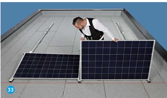
Nächstes Modul in der Mitte mit angegebenem Abstand (siehe Bild 28) ausrichten.
