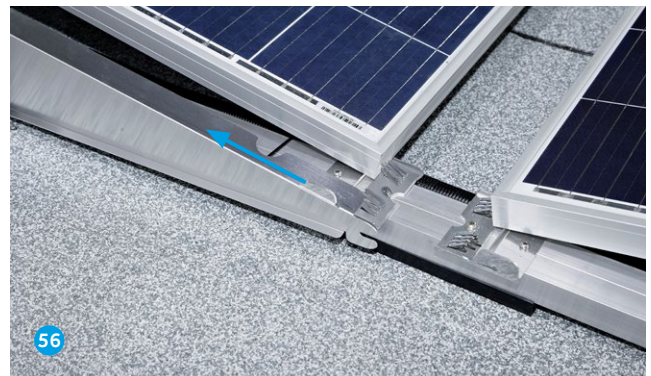
Seitenblech nach hinten ziehen und in die Lasche schieben.
