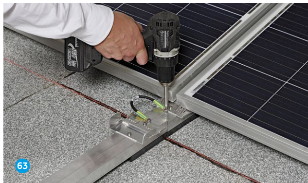
Bohrschraube Flachkopf 4,8 x 16 mm Antrieb AW 25 (im Servicepack enthalten)
