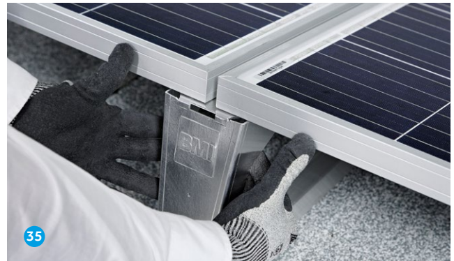
Heckträger, an dem beide Module aufliegen, aufrichten und in die Lasche des Heckträgers schieben. Diesen Montageschritt für alle in einer Reihe liegenden PV-Module wiederholen. Die maximale Reihenzahl beträgt 12 Module nebeneinander.
