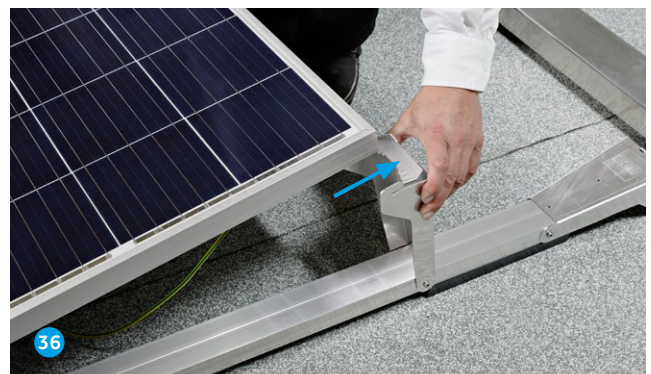
Heckträger seitlich aufrichten und in die Lasche einschieben.
