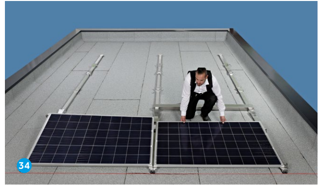
Modul ablegen und wie in Bild 29 bis 31 beschrieben verlegen.
