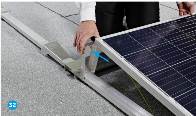
Lasche des Heckträgers in den Modulrahmen schieben.
