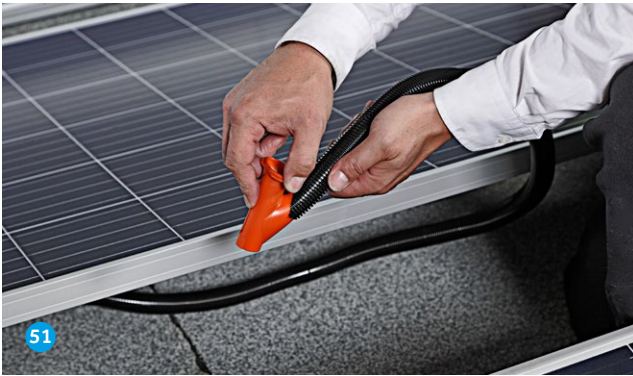
Die geschlossene Nase in das Schutzrohr einlegen.
