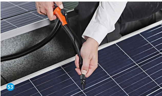
Das Werkzeug im Schutzrohr nach hinten schieben, bis das Kabel komplett am anderen Schutzrohrende austritt.
