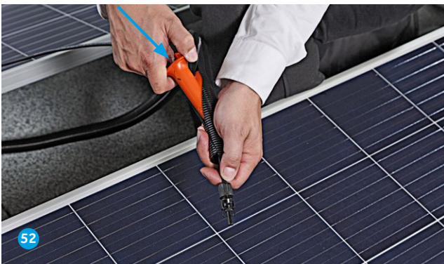
Kabel einschieben und am Rohrausgang fixieren.
