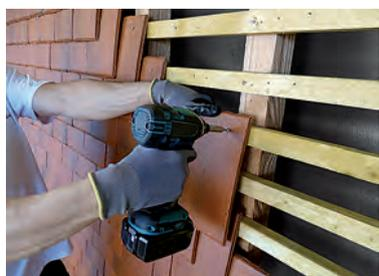
Les tuiles plates sont fixées par 2 vis minimum.
