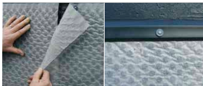
Recouvrement de Fonda GTX
