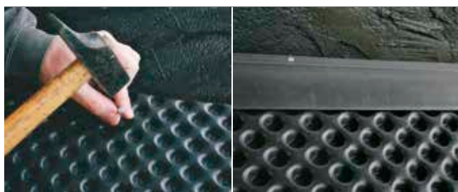
Fixation de la membrane Prim'Nap à l'aide des Prim'Nap Fixations.
