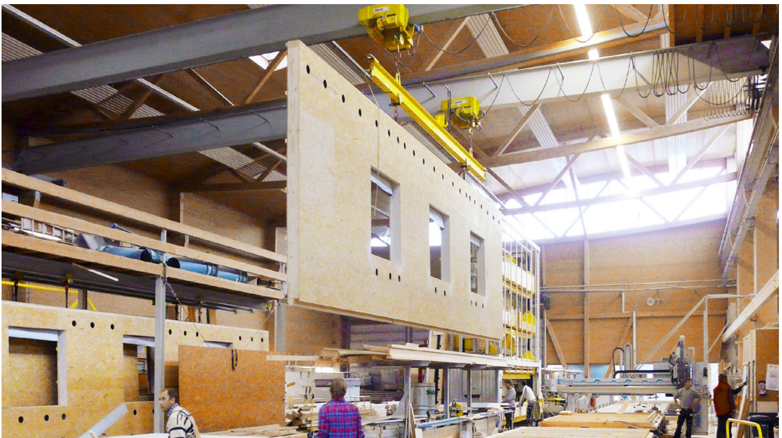
Abb. 2: Vorfertigung eines Fassadenelementes
