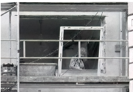
Abb. 46 und 47: Neues Fenster im Fassadenelement; Rückbau des vorhandenen Fensters – durch Montage des vollständigen Elements ist die Belastung der Bewohner gering
