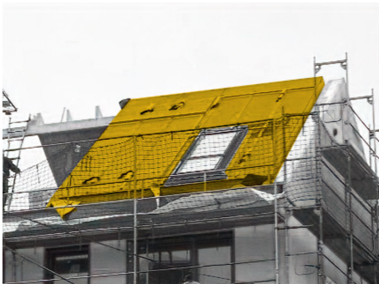
Abb. 42: Montage vorgefertigter Dachelemente (Außenansicht)
