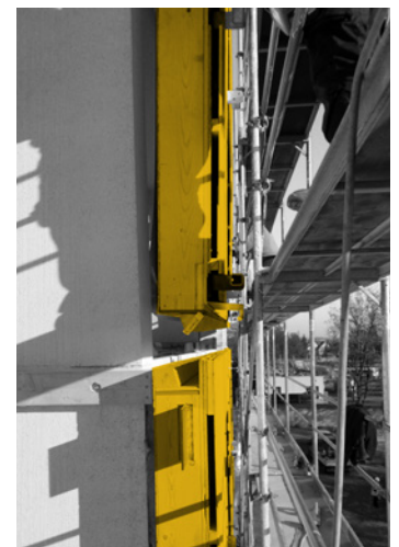
Abb. 78: Ausrichten und Verbinden der Elementstöße
