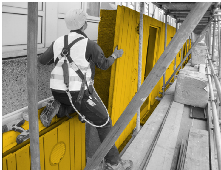
Abb. 70: Elementstoß mit Mineralwolle zur Schallentkoppelung
