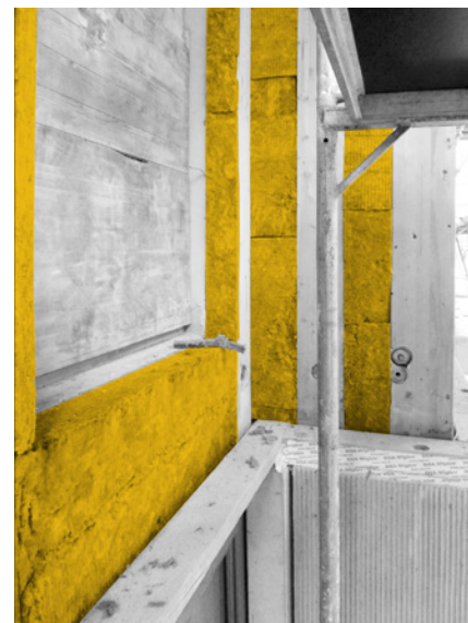
Abb. 71: Ausgleichsebene aus Mineralwolle
