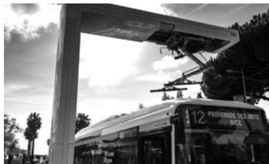
▲ Métropole Nice Côte d'Azur / RLA Régie Ligne Azur / Nice Étude et réalisation d'infrastructures de recharge rapide de bus électriques en milieu urbain équipées de pantographes. Study and implementation of a rapid recharging infrastructures for electric buses in urban areas equipped with pantographs. By Snef
