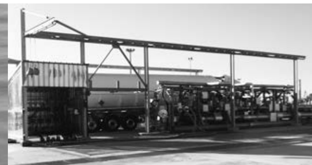
▲ Fosmax LNG / Fos-sur-Mer Extension d'une station de chargement de camion en GNL, accès et zone de déchargement (doublement de capacité). Extension of the LNG truck loading station, access and unloading area (doubling of capacity). By Ekium
