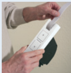
Gurtband einziehen und befestigen
