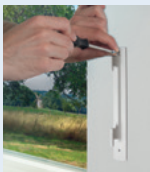
Wandhalterung montieren
