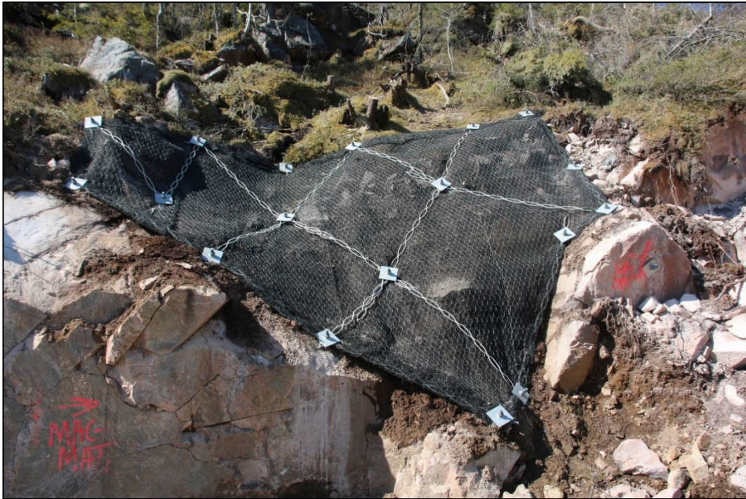
Figur 58: Geonett og fjellbolter er benyttet for å forhindre erosjon av løsmasser og sikre en veiskråning.
