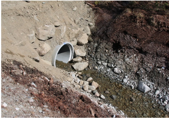
Figur 63: Ulik utførelse for sikring mot erosjon i inn og utløp av kulverter. Grøfter uten plastring, som i eksemplet til venstre, vil over tid være utsatt for erosjon ved stor vannføring. Plastringen må utformes med stein av tilstrekkelig størrelse og høyde tilpasset vannføring og vannhastighet, slik som på bildet til høyre
