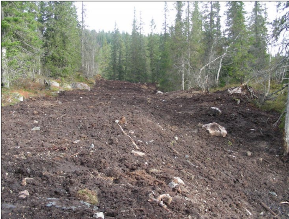
Figur 53: Tilbakeføring av anleggsvei til kjøresterkt terreng. Veikroppen ligger igjen under og vekstmassene legges oppå.
