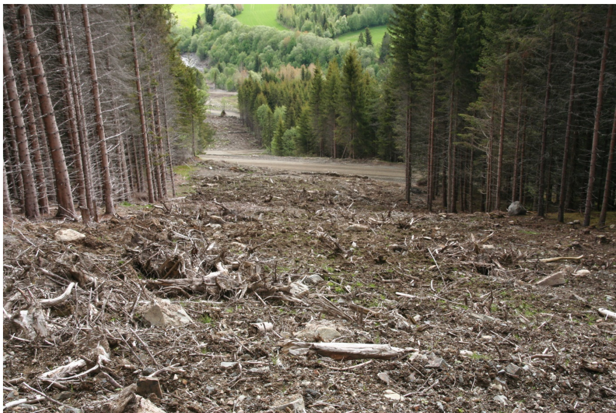
Figur 65: Omfanget av hogstavfall i overflaten bør begrenses, og oppgravde stubber, røtter og stammer bør i størst mulig grad fjernes.
