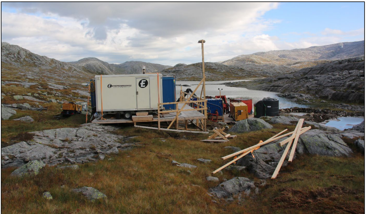
Figur 16: I sårbart terreng kan riggområdet bygges oppå terrenget ved bruk av treverk og/eller plater. Lett å fjerne, og gir minimal skade på terrenget.
