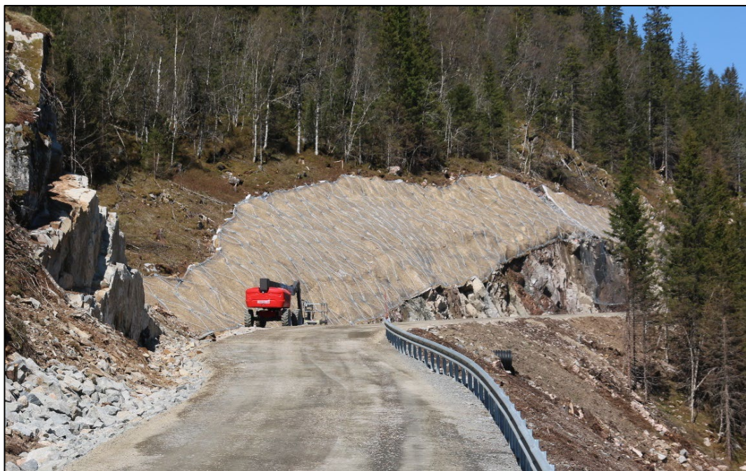
Figur 59: Bruk av geonett og kokosmatter til sikring av veiskråning mot erosjon av løsmasser.
