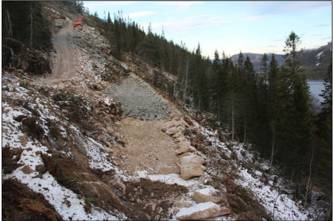
Figur 34: Ved bygging i sidebratt terreng vil det være areal- og arbeidsbesparende å etablere en støttemur av stor stein i foten av veifyllingen. På bildet ser vi oppbygging av den permanente veien med steinblokker, etter at det først er etablert en mindre anleggsvei i overkant. Det er viktig å rydde/sette i stand langs fyllingsfoten før veien bygges opp, da det kan være vanskelig å komme til i ettertid.
