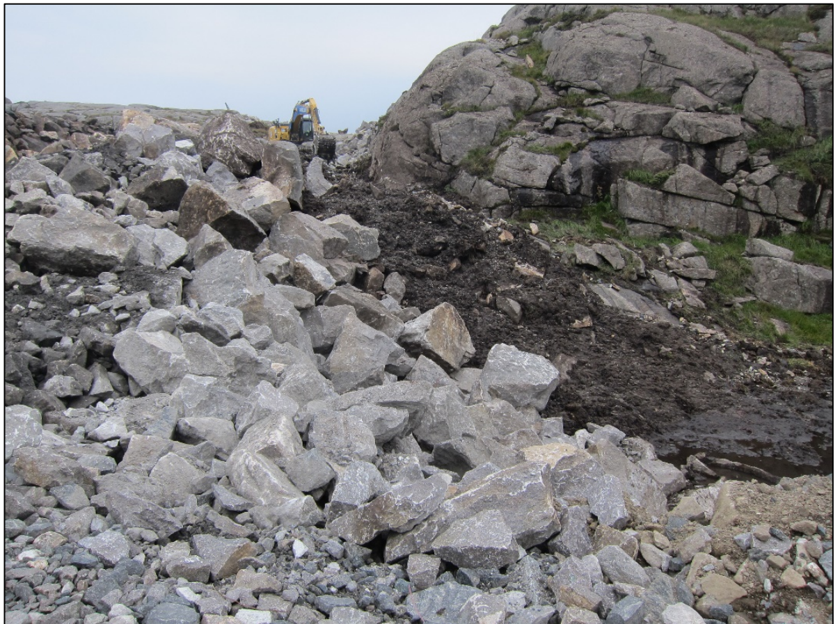
Figur 19: Stor sprengstein som må pigges ned, tildekkes eller fraktes bort.
