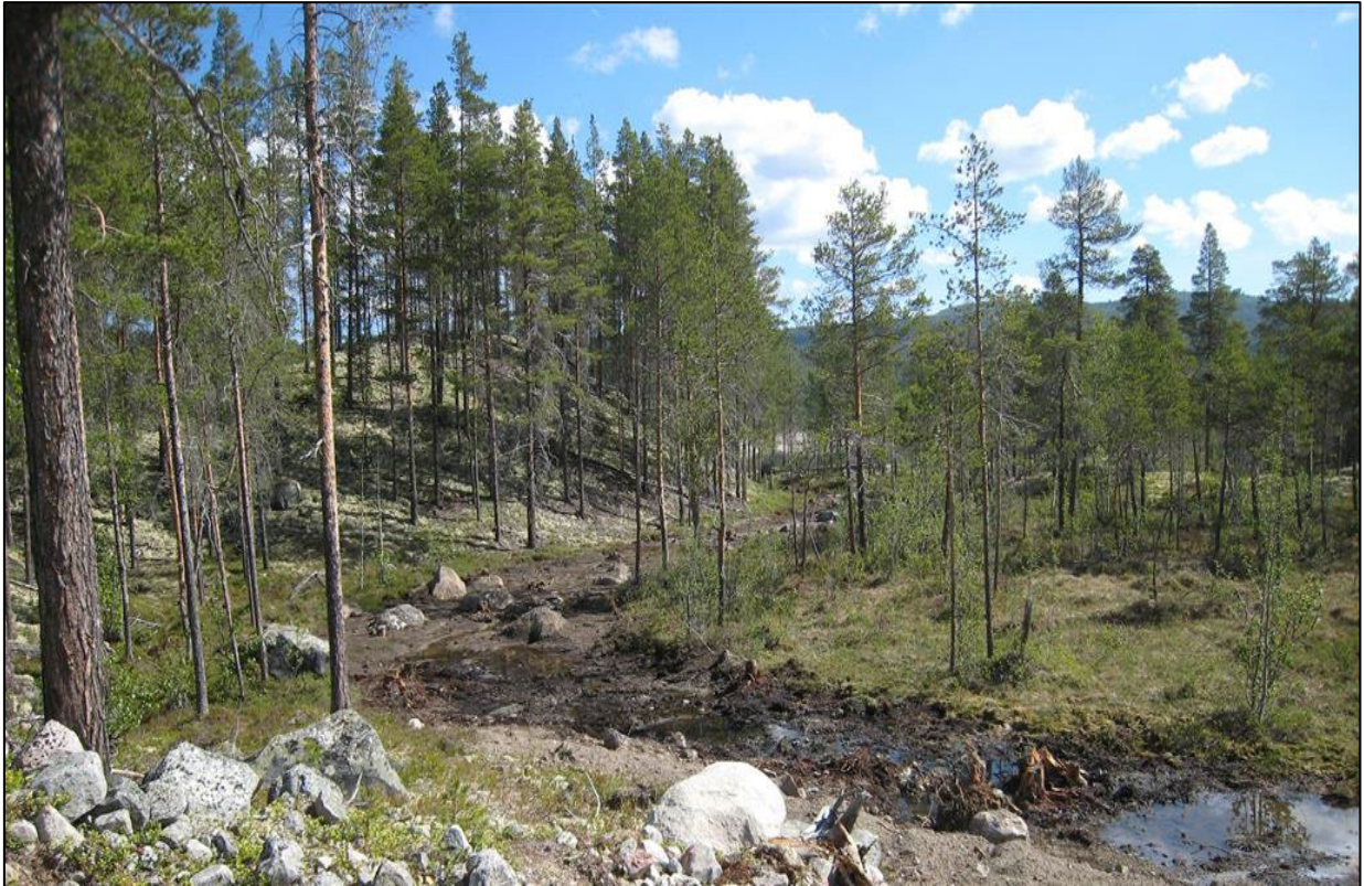
Figur 35: Istandsatt midlertidig anleggsvei der det er lagt tilbake stor stein i overflaten for å etterligne omgivelsene.
