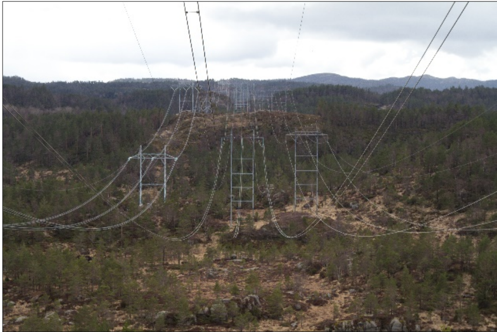
Figur 11: Her er ledninger strukket over stående skog. Dette bidrar til å dempe inntrykket av ryddegata.
