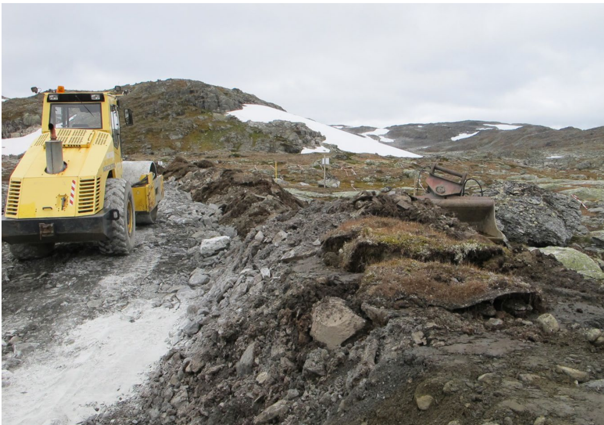
Figur 23: Mellomlagring av hele vegetasjonsflak. Foto: Norconsult AS.
