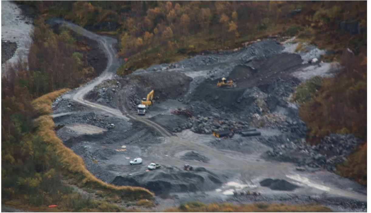
Figur 48: Lager for overskuddsmasser fra tunneldrift. I nedkant av området er det lagt opp en voll av avdekningsmasser for å få bedre kontroll på og avgrense massene etter hvert som lageret fylles.
