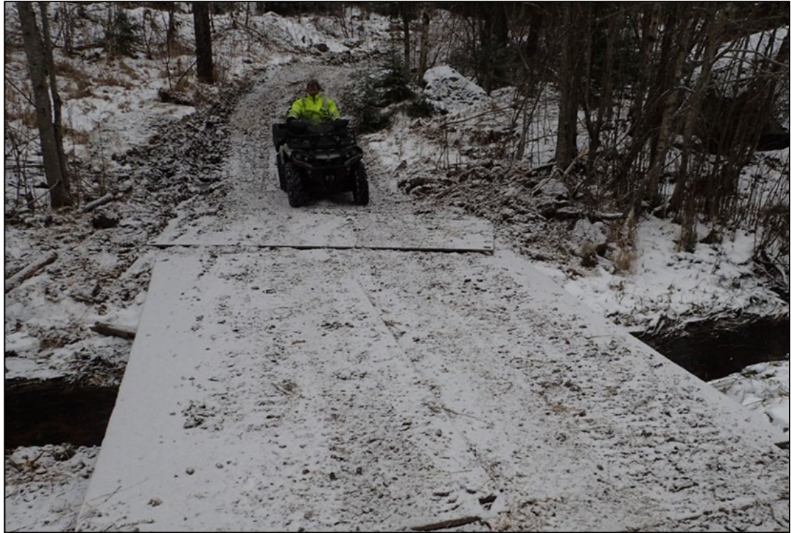
Figur 39: Bekkekryssing ved bruk av plater. Foto: Norconsult AS.
