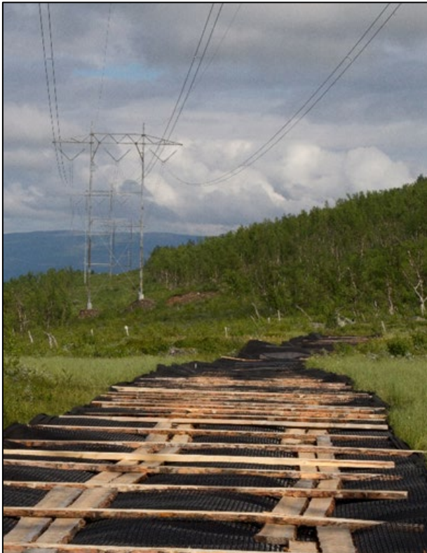
Figur 40: Ulike eksempler på terrengforsterkende tiltak. Foto til høyre: Lofotkraft AS.
