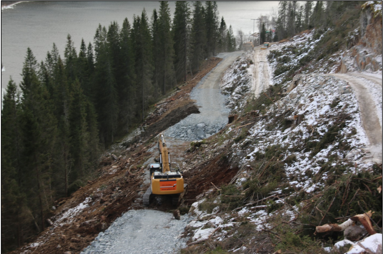
Figur 5: Bygging i sidebratt terreng gir store fyllingsutslag. Dette kan gjøre oppryddingen (hogstavfall og sprengstein) og istandsetningen svært krevende. Tidspunkt og metode for gjennomføring av oppryddings- og istandsetningsarbeidet må derfor planlegges godt.
