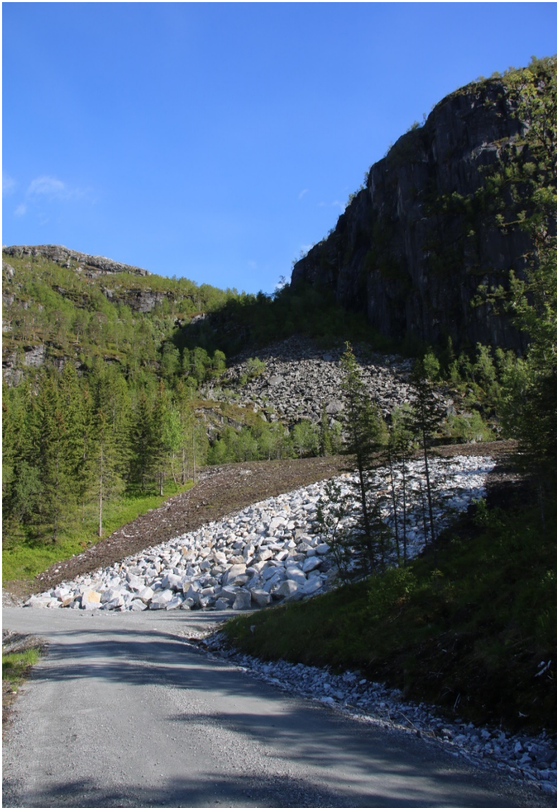
Figur 50: Permanent lager av overskuddsmasser fra tunnel hvor forming og istandsetting er gjort bevisst for å etterligne landskapselementet (naturlige skredmasser) over.
