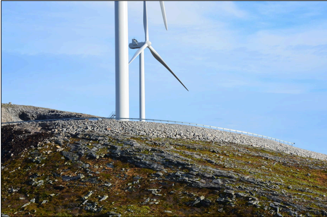
Figur 32: Her ligger veien på en sprengsteinfylling som er lagt opp av stein med avtakende størrelse opp mot veibanen. Et eksempel på en veifylling som står seg godt i landskapet.
