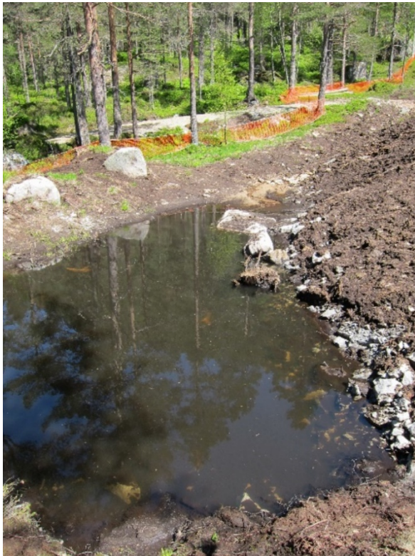
Figur 51: Et sedimentasjonsbasseng som håndterer avrenning fra lagrede myrmasse. Bilde til høyre viser et akutt tiltak der halmballer er benyttet for å filtrere ut sedimenter i bekk nedstrøms en kulvert.
