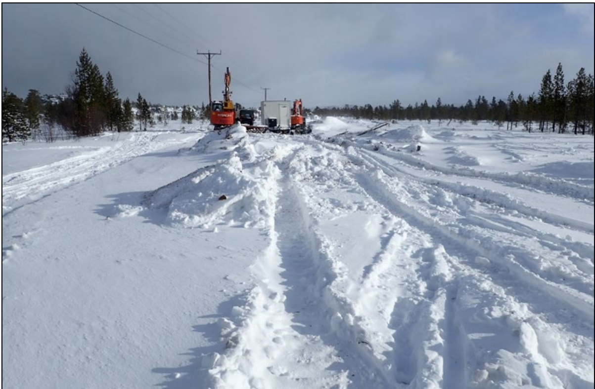
Figur 38: Vinterarbeid med transport på snø og frossen mark gir spesielt stor gevinst på myr og i vått terreng der terrengskadene ellers kan bli omfattende.
