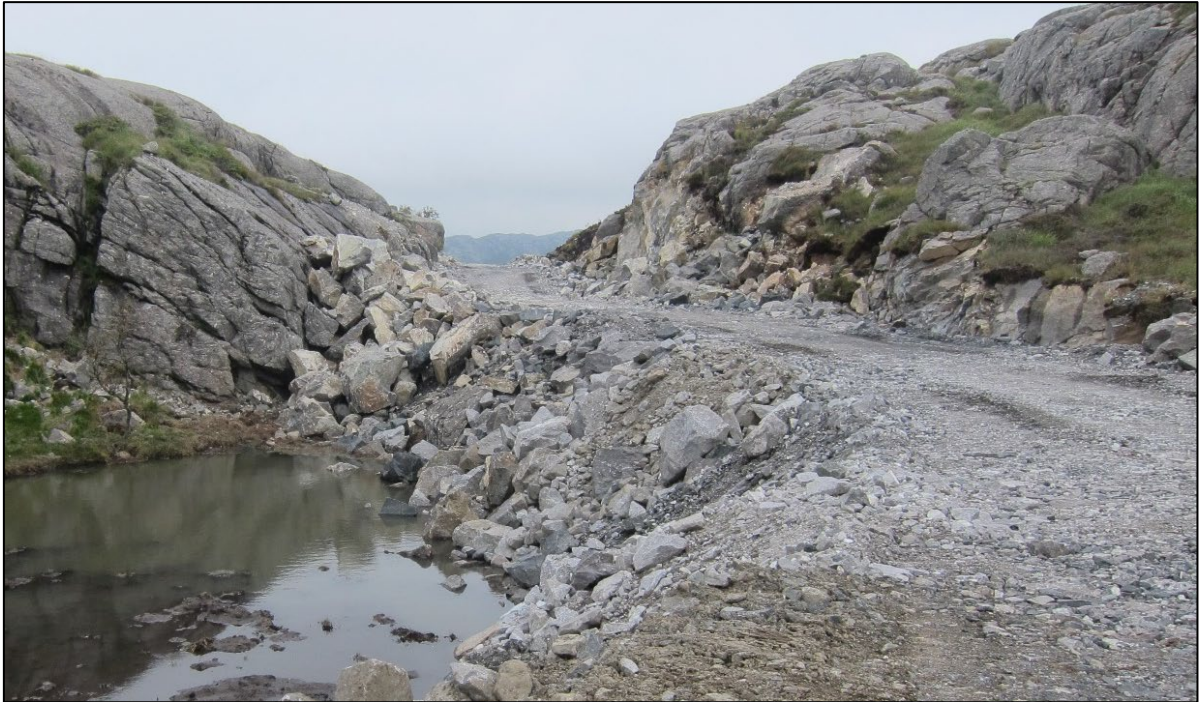
Figur 20: Det som spares av tid og ressurser innledningsvis, vil ofte føre til økt tids- og ressursbruk når området skal istandsettes. I tilfellet som vist på bildet må grov stein pigges ned, overgangen til vann ryddes og avgrenses, og myr- og steinmasser som har havnet i vannet må fjernes.
