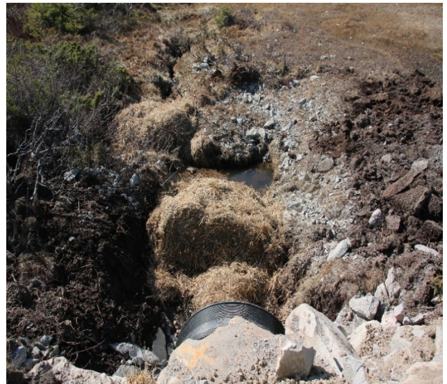
Figur 51: Et sedimentasjonsbasseng som håndterer avrenning fra lagrede myrmasse. Bilde til høyre viser et akutt tiltak der halmballer er benyttet for å filtrere ut sedimenter i bekk nedstrøms en kulvert.
