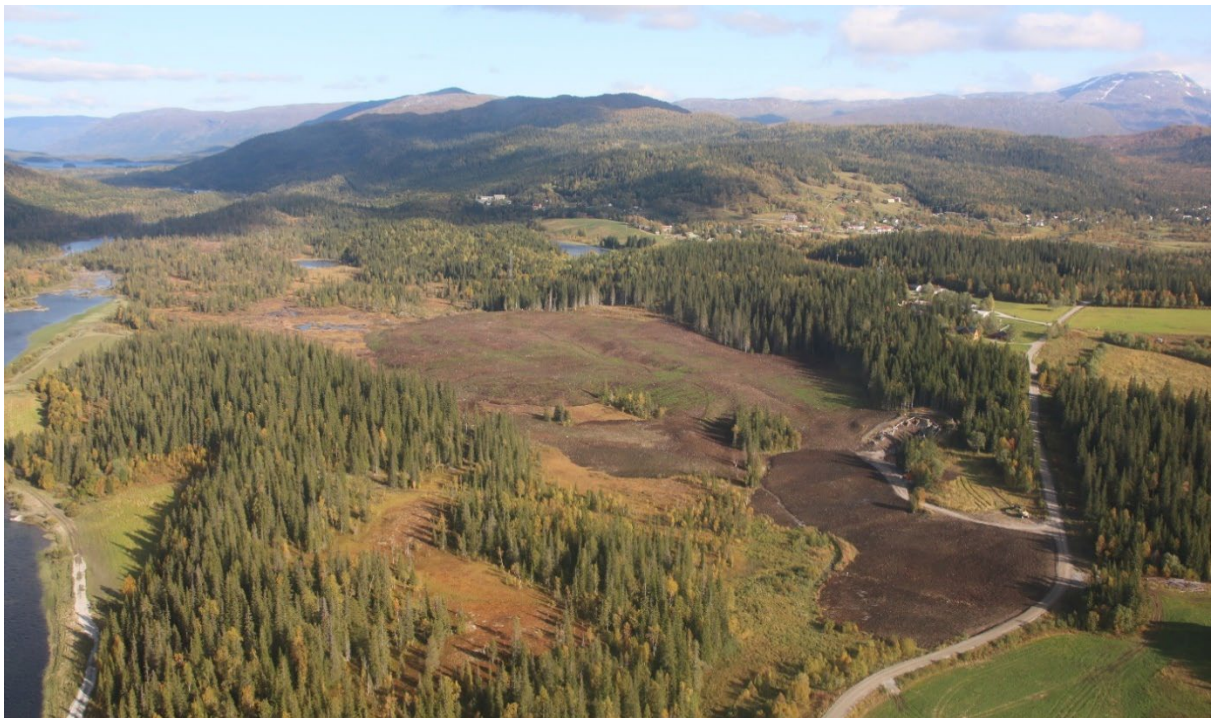
Figur 49: Ferdig istandsatt lager for ca. 650 000m 3 tunnelstein. Flekkvis tilsåing med stedege frø for rask vegetasjonsetablering.
