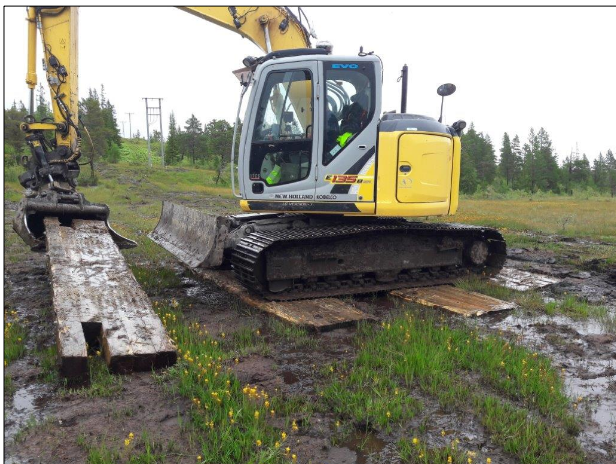
Figur 36: Bruk av stokkmatter ved transport av gravemaskin 14 tonnkjøresvakt terreng. Foto: Statnett.
