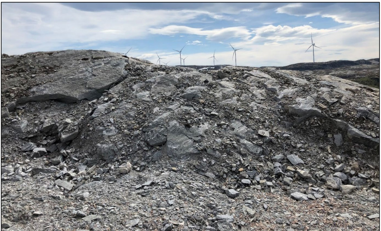
Figur 21: Eksempel på sprengsteinsøl som må kostes eller spyles av det bare fjellet.
