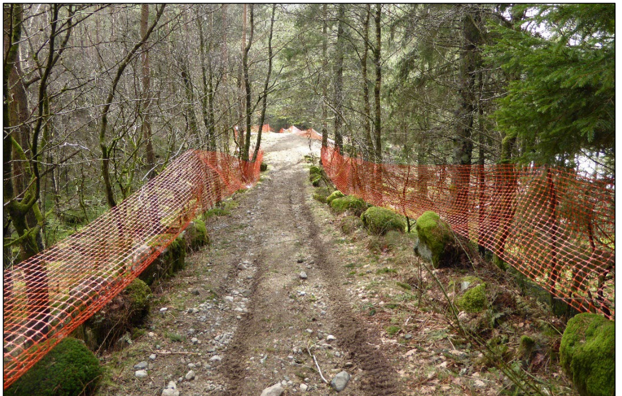
Figur 7: Kjøretrasé markert med alpingjerde for å unngå berøring av sideterrenget.
