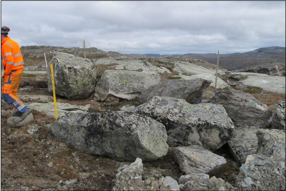
Figur 22: Mellomlagring av naturstein med den patinerte siden opp. Foto: Norconsult AS.
