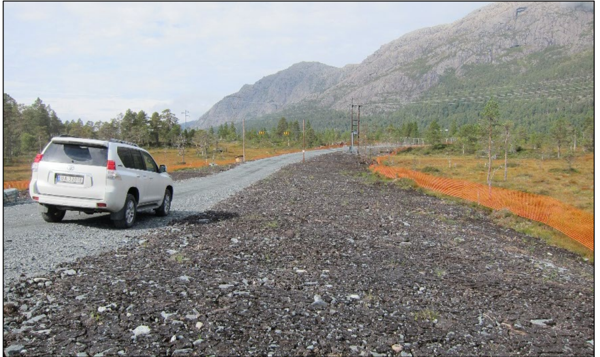
Figur 6: Nybygget vei der inngrepsgrensen er markert med alpingjerde i terrenget. Det er ingen spor etter anleggsvirksomhet utenfor gjerdet.
