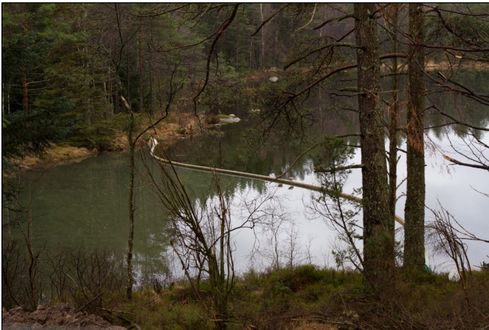
Figur 52: Bruk av siltgardin ved fare for avrenning til vann og vassdrag.
