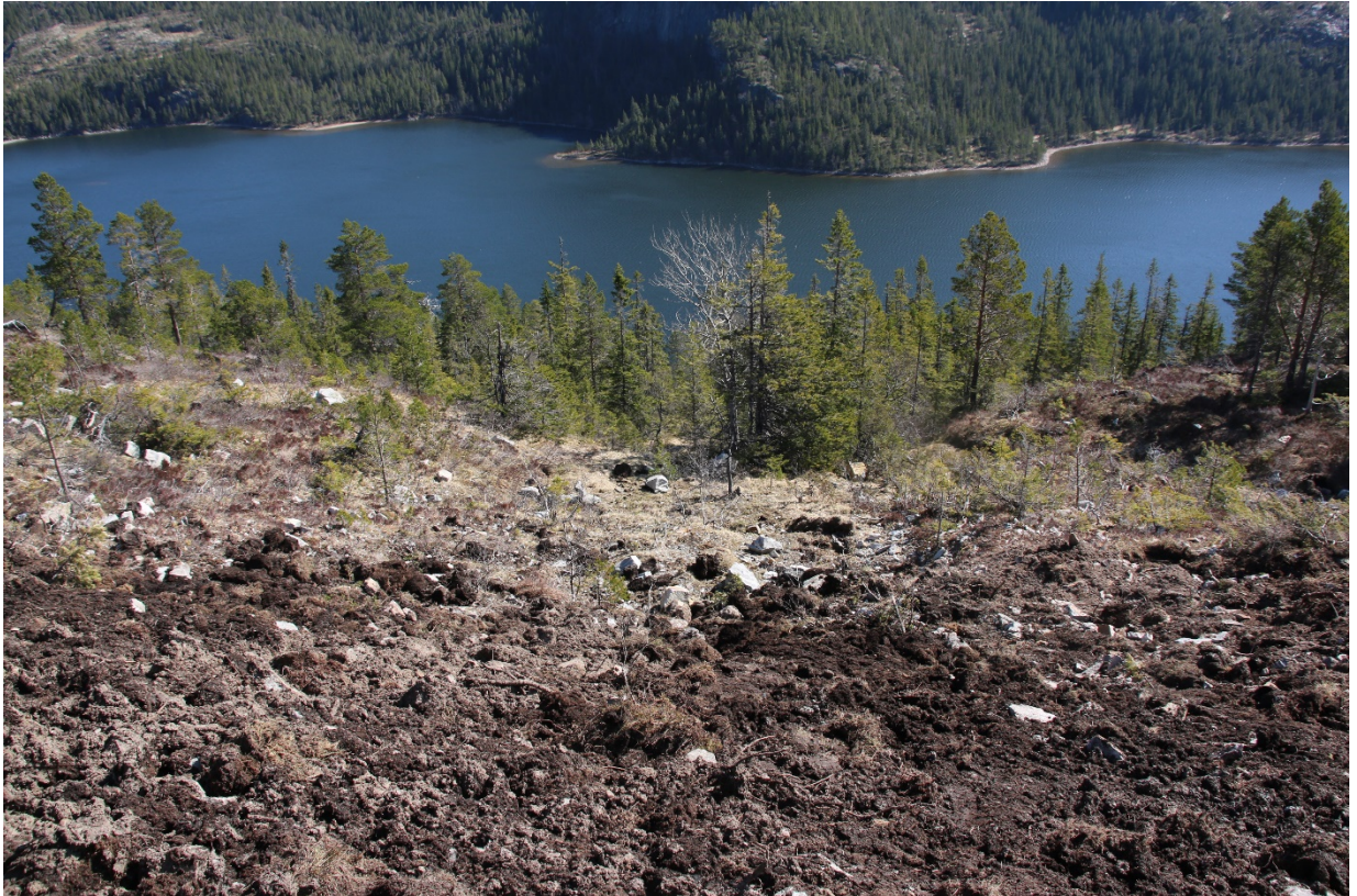
Figur 66: Sprengstein spredt i terrenget utenfor vedtatte inngrepsgrense kan ansees som et brudd på vedtatt plan. Spredning av sprengstein skal unngås og skal i størst mulig grad fjernes.
