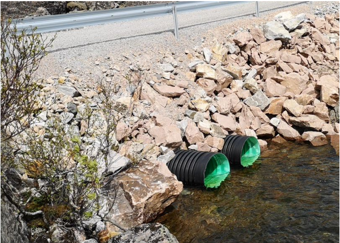
Figur 64: Eksempel på uheldig fargesetting og mangelfull avslutning (skråkapping) av drensør. En mørk og dempet farge vil fungere best under de fleste forhold. Veifyllingen er uryddig og burde vært plastret med stor stein lagt opp planmessig, eller vannkanten burde vært gjenskapt.
