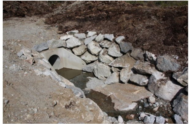
Figur 63: Ulik utførelse for sikring mot erosjon i inn og utløp av kulverter. Grøfter uten plastring, som i eksemplet til venstre, vil over tid være utsatt for erosjon ved stor vannføring. Plastringen må utformes med stein av tilstrekkelig størrelse og høyde tilpasset vannføring og vannhastighet, slik som på bildet til høyre
