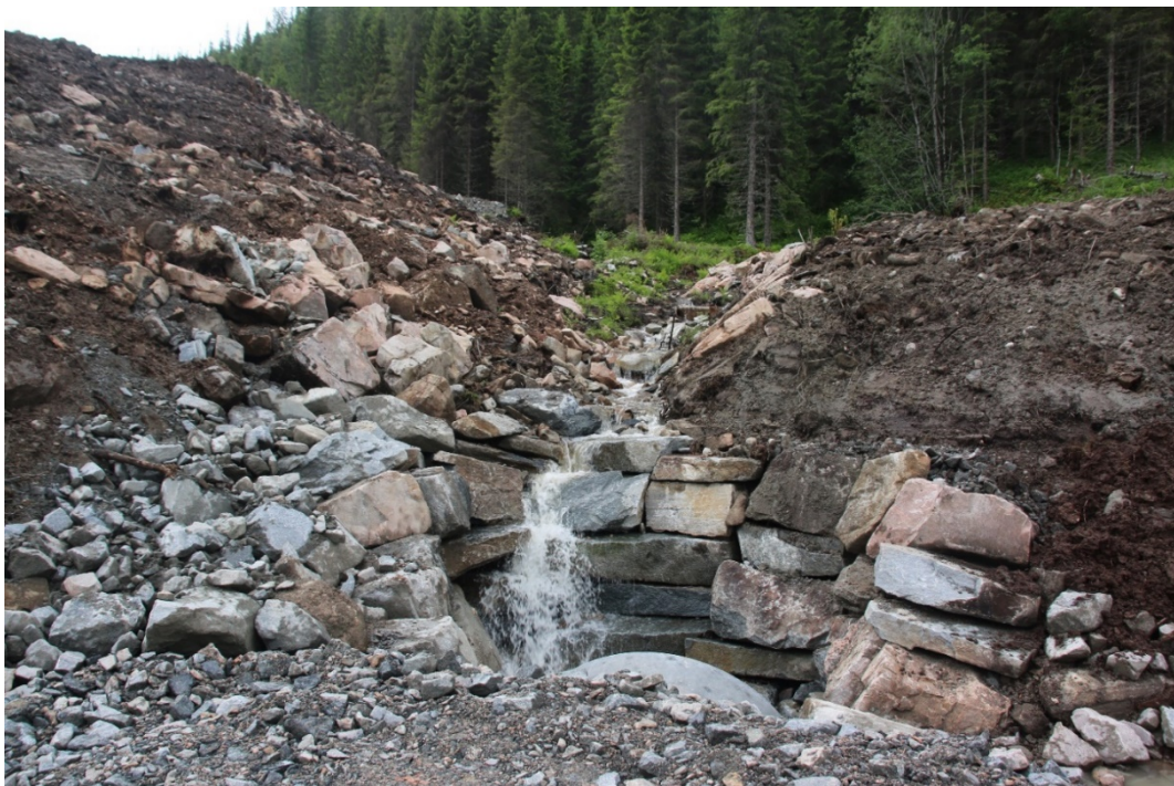
Figur 62: Utførelse av grøft og innløp til kulvert som bidrar til å sikre mot erosjon.
