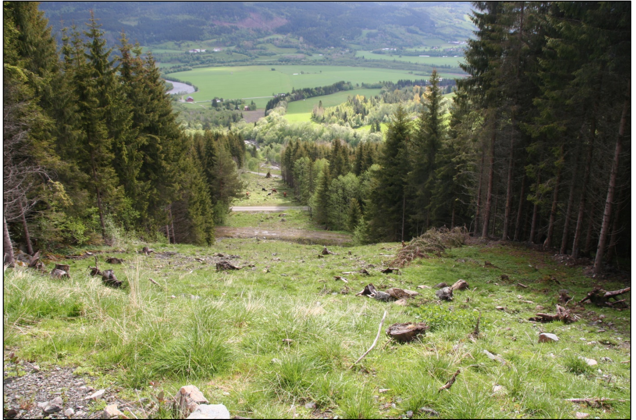
Figur 8: Rettlinjet rørgatetrassé gjennom ensartet granskogsbestand gir et svært markert spor i landskapet. Her ville «frynset» hogst i sidene, eller en vinkling av rørgatetrasséen kunnet dempet virkninger av rørgatetrasséen.
