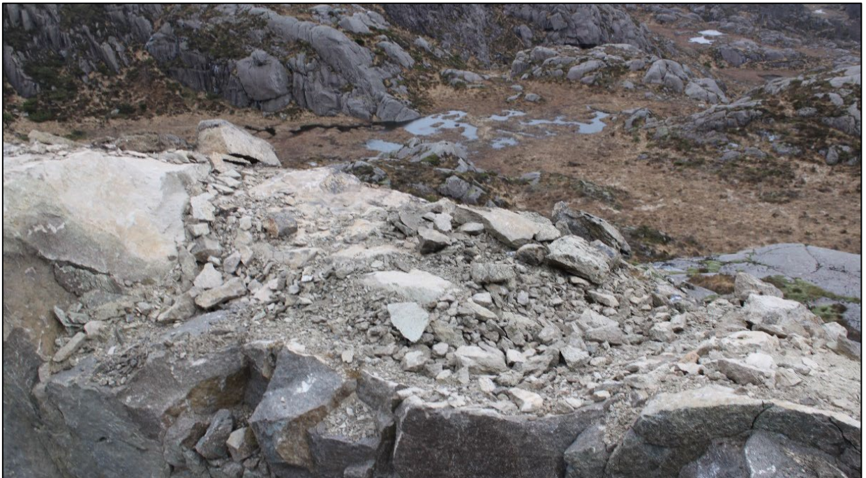
Figur 67: Sprengsteinsøl gir et rotete og uferdig inntrykk og skal i størst mulig grad fjernes (tildekkes, kostes eller spyles bort).
