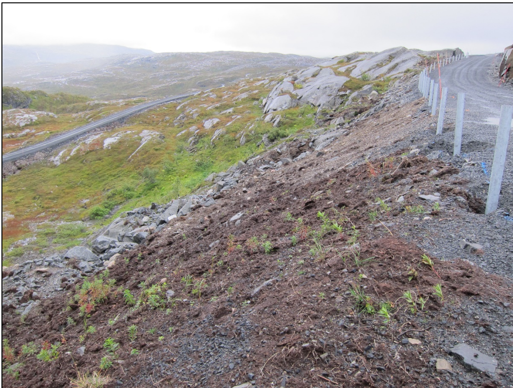
Figur 55: Her er avskavede vekstmasser lagt ut flekkvis på en mettet sprengsteinsfylling. Ulike arter spirer allerede den første vekstsesongen under forholdsvis tøffe klimatiske forhold (Narvik).
