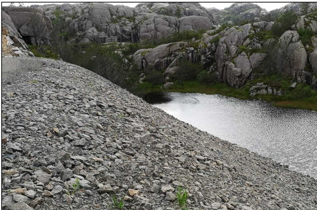
Figur 56: Sprengsteinsfylling påført steinmasser med en del finstoff (0-fraksjon). Allerede året etter ser vi de første tegnene på vegetasjonsetablering (Rogaland).
