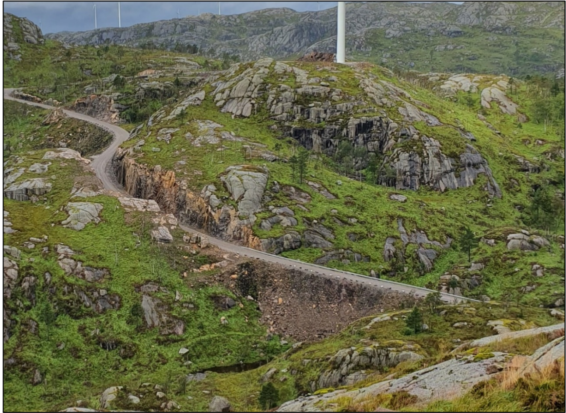
Figur 4: Dobbeltsidig fylling som krysser et vassdrag. Dette er en uheldig løsning som gir store fyllinger på tvers av terrengformene. Den tosidige skjæringen lenger til venstre er et stort og irreversibelt inngrep, men sparer inngrep i sideterrenget og skjuler veien på avstand.
