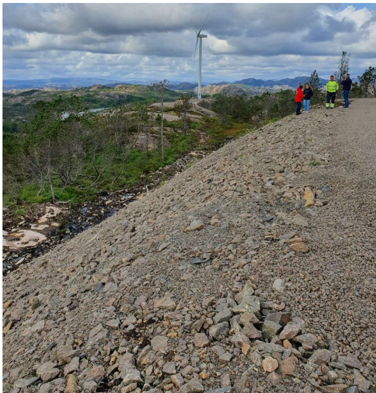
Figur 31: I dette anlegget var det mangel på vekstmasser til arrondering av sprengsteinsfyllingen. I stedet for vekstmasser er det lagt på steinmasser med en mindre og mer homogen fraksjonsstørrelse. Dette gir sprengsteinfyllingen et mer ryddig preg. Dersom de påførte massene inneholder en del finstoff som metter fyllingen og holder på fuktighet, vil det etableres vegetasjon over tid.
