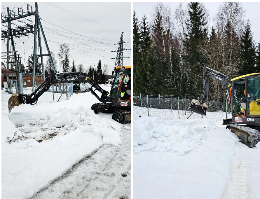
Figur 4. Bildene viser deler av tiltaksområdet hvor det er planlagt gravetiltak i forbindelse med utvidelse av Dal transformatorstasjon i Eidsvoll kommune. Foto: Rambøll, 2024.
