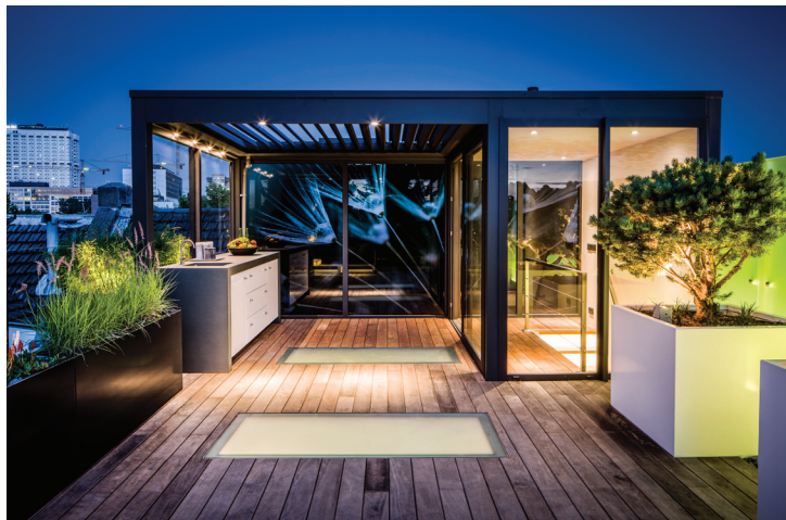
De blikvanger op dit dakterras is het glazen dakhuis met elektrisch bedienbare lamellen van Livium.
