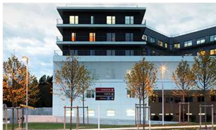
© Valode & Pistre architectes, photos Philippe Chancel
