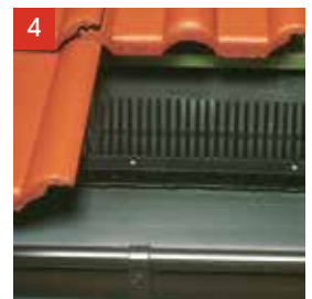
4 TRAUFE Zur Absperrung gegen Vogeleinflug an der Traufe (Traufgitter, Aero Traufelement)
