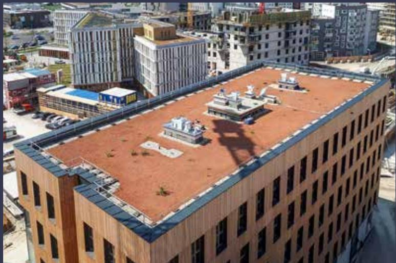
Bilder: **HoHo Wien**: Das Dach des HoHo Wien wurde als Warmdach konzipiert und die BMI Villas-Bahnen kamen bei der Garagendecke, bei den Terrassen im 2., 10. und 16. Obergeschoss sowie am Hauptdach im 23. Obergeschoss zum Einsatz.
