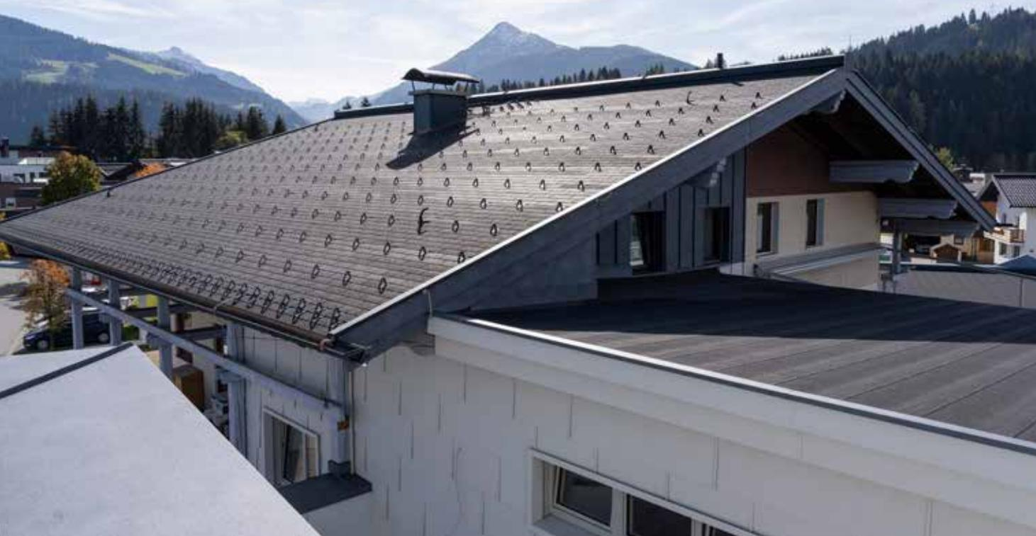
Bei den Steildächern wurde ein DichtDach mit PM-Schindeln von BMI verlegt. Dieser 100-prozentig wetter- und sturmefeste Dachwerkstoff, der mit einer flächig verklebten Deckung überzeugt, wurde in der Farbe anthrazit gewählt. Für das erhöht regensichere Unterdach wurde die Villasub UDS E-3 als bituminöse Unterdeckbahn eingesetzt. Darüber wurde als Vordeckbahn die Villasub E-KV-15 NSK aus Elastomerbitumen verlegt.
