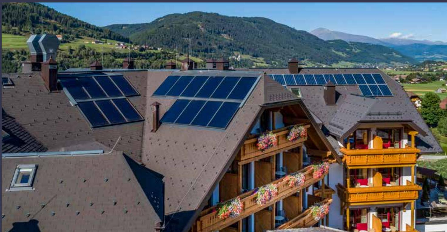
Bild oben: **Hotel Central Flachau** – Das Dach ist mit DichtDach PM-Schindeln eingedeckt, der 1.000 m<sup>2</sup> große unterirdische Funpark ist mit einem intensiven Gründach von BMI Villas abgedichtet.
