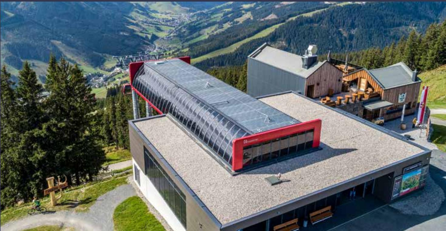
Bild oben: **Schlossalmbahn Bad Hofgastein** – für die Abdichtungslösungen der weitläufigen Flachdachflächen kamen insgesamt sechs verschiedene Bitumenbahnen von BMI Villas zum Einsatz.
