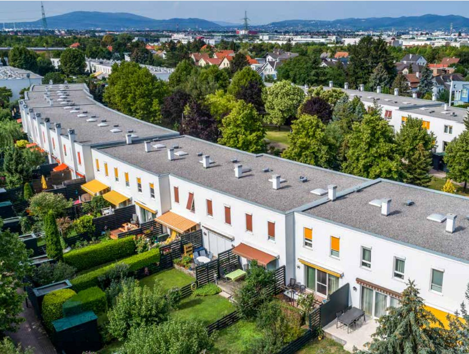
Bild oben: **Wohnhausanlage Tenschertstraße, Wien:** Auf einer Fläche von 50.000 Quadratmetern wurden die Villas-Produkte Villaself E-4 SK und Villatop DUO dolomitgrau aufgetragen.
