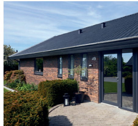
70'ER PARCELHUS med topstyrede vinduer
