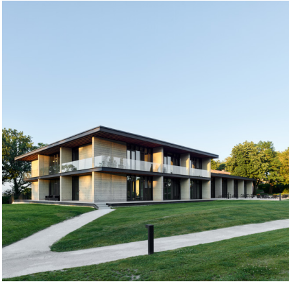
Fondation P Lavour (81)
