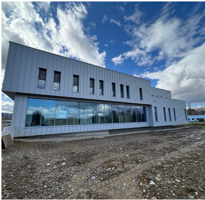
Bureaux, showroom et dépôt Mulhouse (68)
