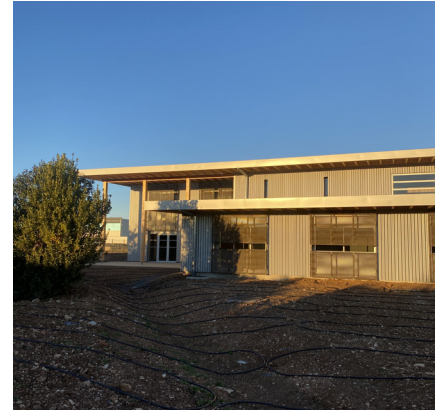
Régie des Eaux Clermont-l'Hérault (34)
