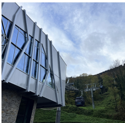
Gares amont et aval de la télécabine Bagnères-de-Luchon (31)
