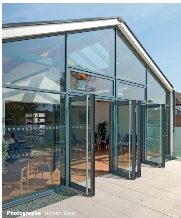
Intégration dans la façade
