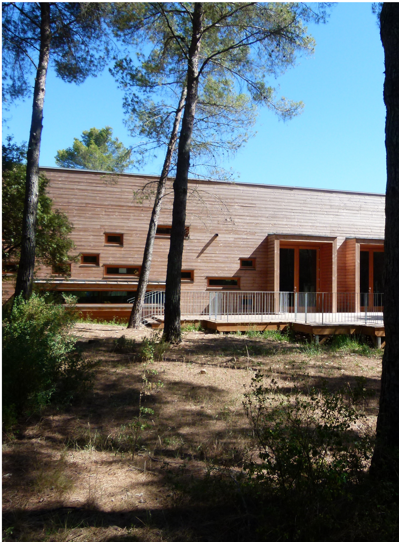
La salle de sport de Saint-Marc-Jaumegarde (13), BDM Or en phase usage. Maître d'ouvrage : Ville de Saint-Marc-Jaumegarde. Architecte : Battesti Associés. Accompagnateur BDM : SOWATT. Photo : ©Frédéric Corset.
