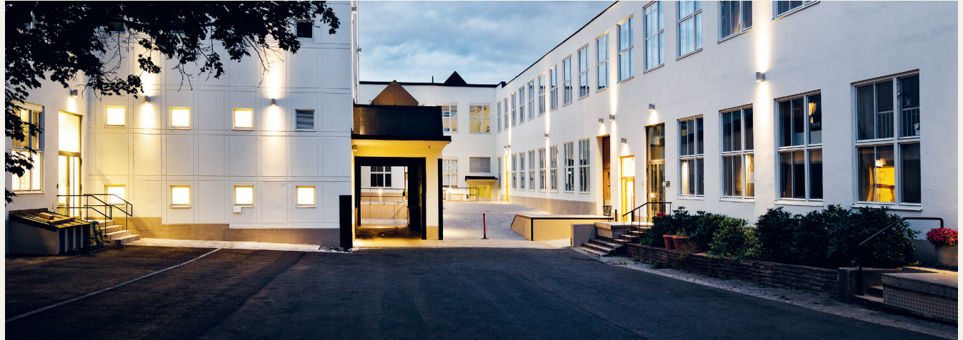
Fastighetsklustret i Bromma
