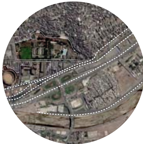
07. EN EL RÍO RÍMAC CONVIVEN BARRERAS FÍSICAS COMO LA VÍA DE EVITAMIENTO Y LÍNEA AMARILLA, Y EQUIPAMIENTOS QUE NO SE INTEGRAN AL TEJIDO URBANO
