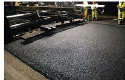
Rubberized asphalt concrete yang bersifat lebih elastis sehingga mengurangi potensi keretakan
