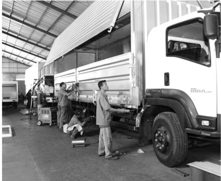
Proses pemasangan wingbox pada body kendaraan
