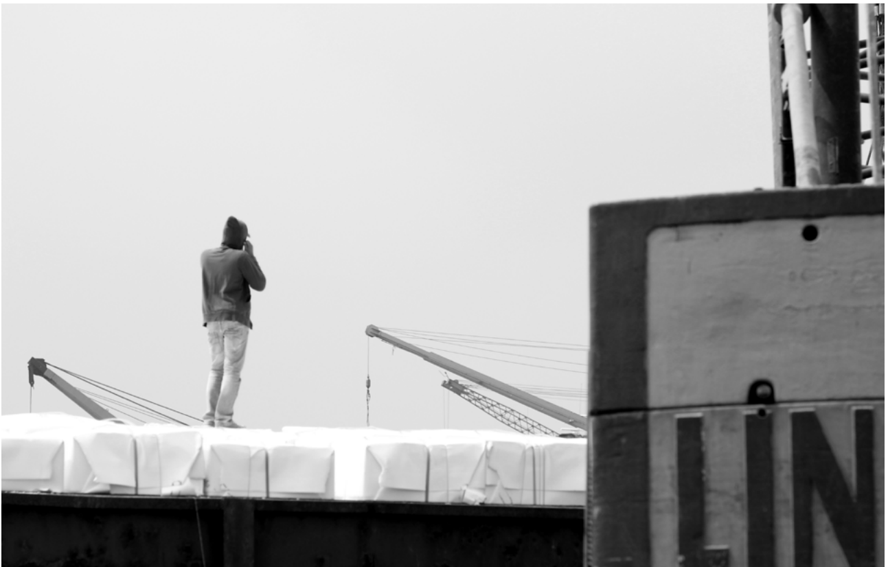
Pemberi intruksi kepada operator crane
