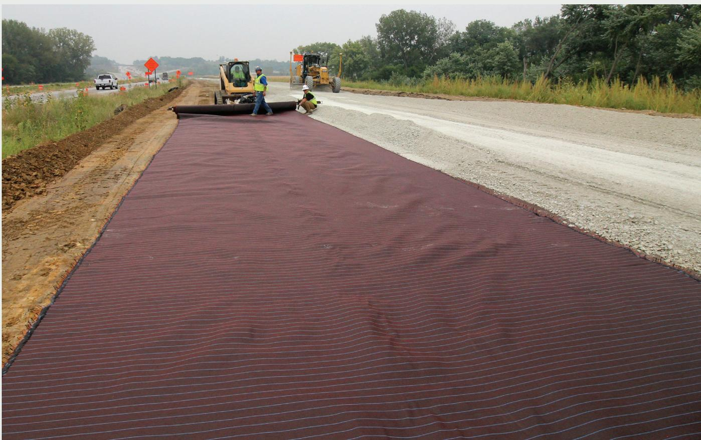
El agua acumulada debajo de las carreteras debilitará la subrasante y provocará daños, incluidos baches y ahuellamiento. El uso de un geosintético con control de la humedad es una forma eficaz de mitigar estos problemas tanto en carreteras pavimentadas como no pavimentadas.
