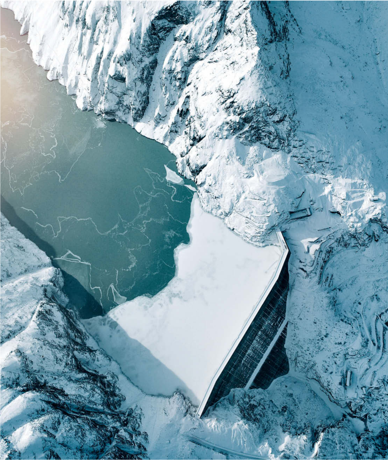
Hohe Ingenieurskunst im Fels: die Grande Dixence. Imposante Mauer, klares Wasser, saubere Energie.
