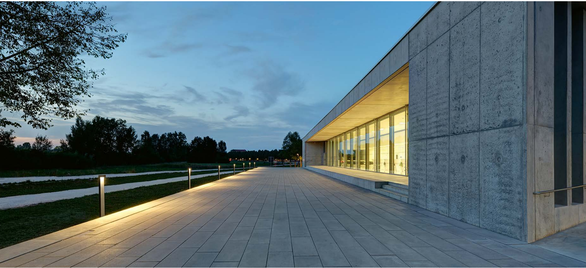
Leuchten in Sonderanfertigung
