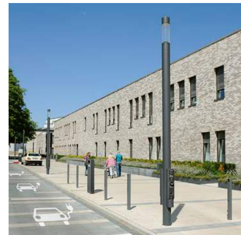
Lichtbauelementrohre mit E-Ladeeinheiten verbinden Sicherheit, Ästhetik und Nützlichkeit: Laden, wo Licht ist!
