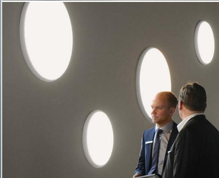
Las luminarias de gran superficie ofrecen una ventaja especial: su alta potencia lumínica se distribuye en una amplia superficie de salida de la luz, de modo que crean una luz suave que se emite de forma homogénea al espacio. Esto permite conseguir potencias lumínicas elevadas sin deslumbramiento perceptible.
