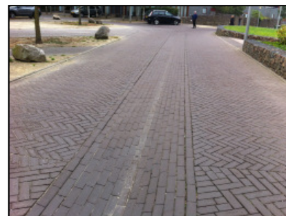
Boligvejene i lokalplanområdet kan etableres med vandrender i græs langs kanten af vejen eller som vist på billedet herover, som en rende i belægningen. Renden kan nemt kryd-ses af biler, cykler og gående.
