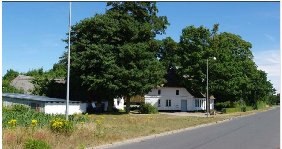
Hvidkærgårdsvej 10, Bastrupminde, har tilkørsel fra Hvidkærgårdsvej.
