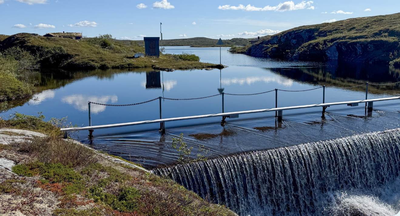
Damanlegg i Skurdalssjøen
