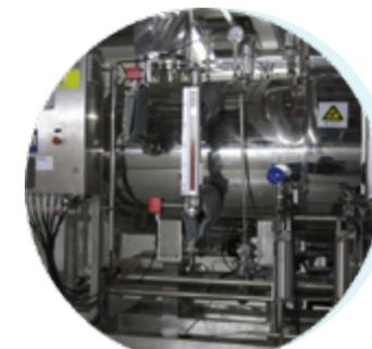
将工业蒸汽和空调系统的冷凝水回收再利用，纯净度可以对标自来水
