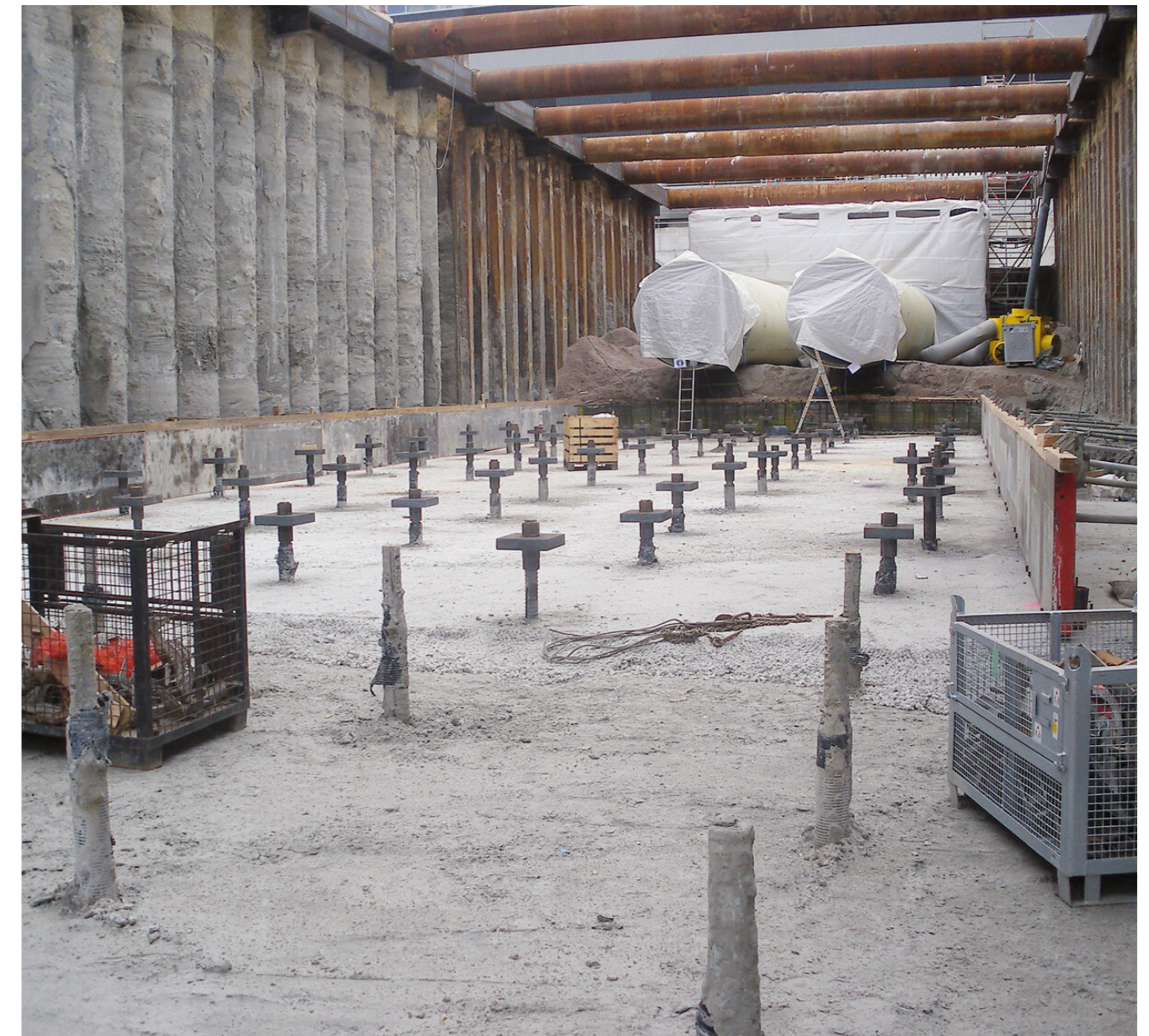
WILHELMSHAVEN POWERPLANT, GERMANY GEWI® PLUS PILES
