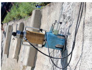
ABHEBEVORRICHTUNG IM EINSATZ
