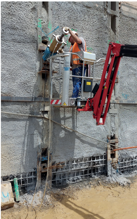
ABHEBEVORRICHTUNG, NACHSPANNEN VON TEMPORÄREN LITZENANKERN (AUCH OHNE LITZENÜBERSTAND ODER AUSSENGEWINDE AM KEILTRÄGER MÖGLICH)
