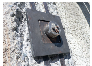
VERGRÖßERUNG DER ANKERPLATTE FÜR SPANNSTUHL, KEILTRÄGER OHNE AUSSENGWINDE
