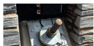
ANKERKOPF MIT SMART ANCHOR
