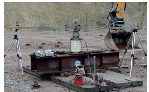
POWER TEAM AGGREGAT IM EINSATZ BEI EINER PFAHLPRÜFUNG MIT CFK PRESSE 250TO
