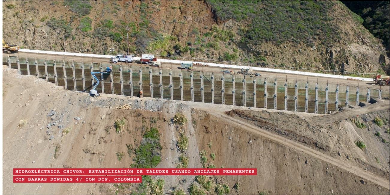
HIDROELÉCTRICA CHIVOR: ESTABILIZACIÓN DE TALUDES USANDO ANCLAJES PERNAMENTES CON BARRAS DYWIDAG 47 CON DCP. COLOMBIA
