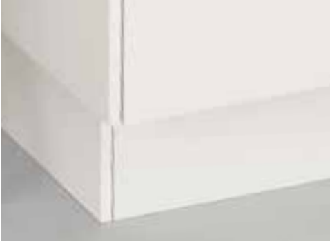
Vanlig inntrukket sokkel
