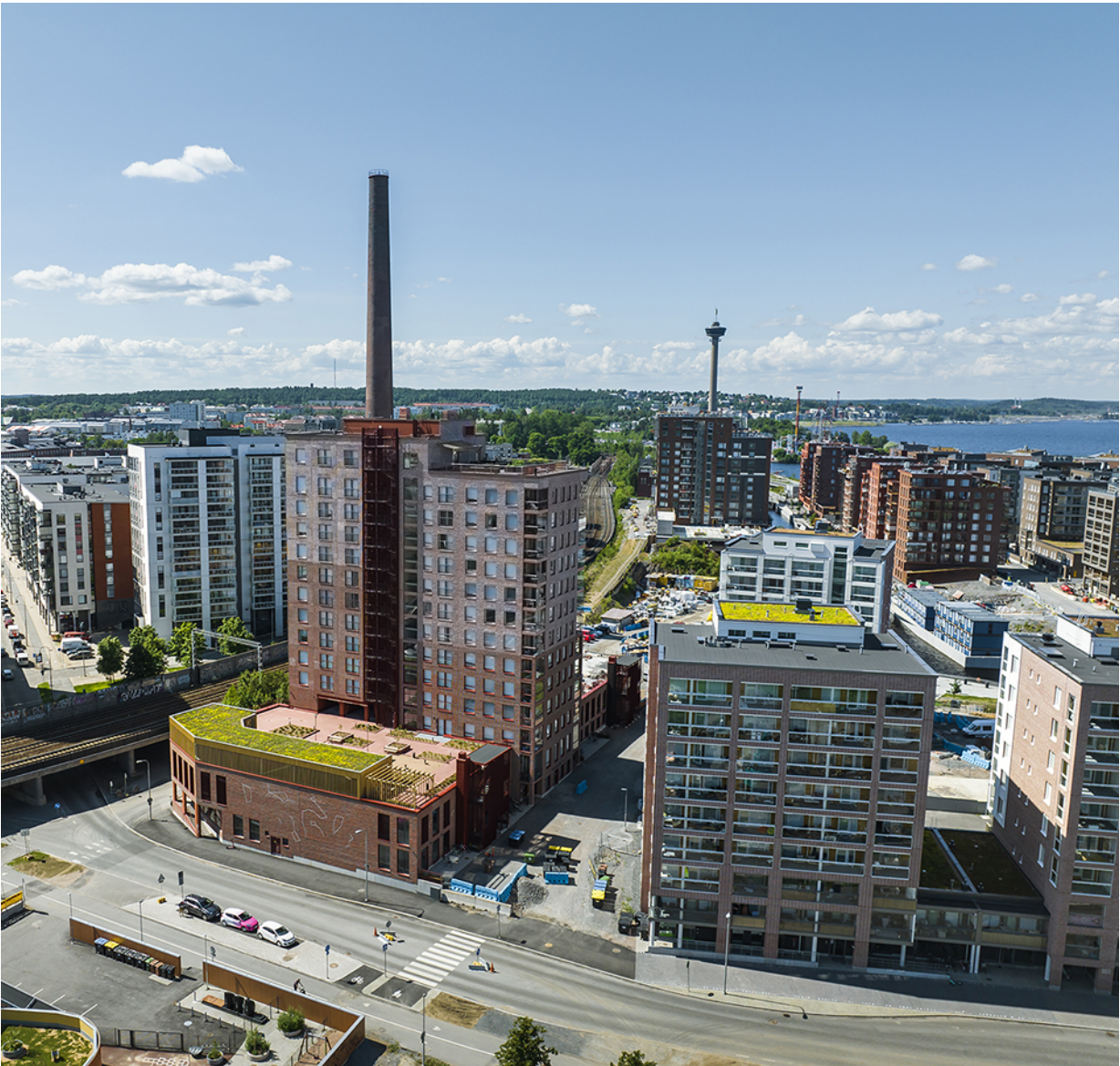
Kiinteistö Oy Tampereen Koelaitoksenkatu 22
