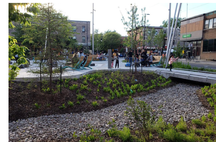
L'aménagement de bassins de rétention des eaux de pluie
