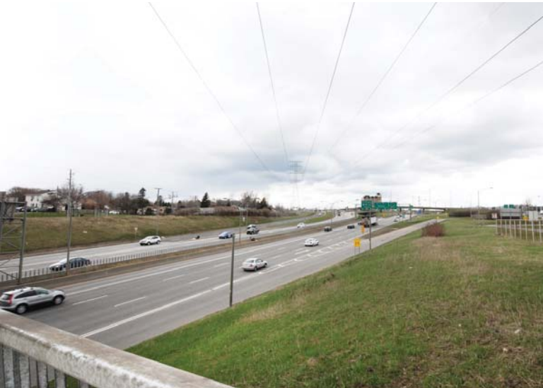
Photo 2 : L'autoroute Henri IV et l'Hôtel Clarion
