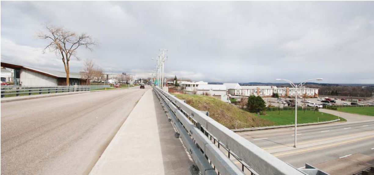
Photo 42 : Viaduc du chemin Saint-Louis surplombant l'autoroute Henri IV
