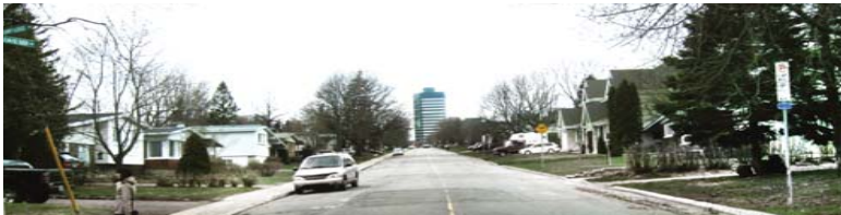
Photo 30 : Vue sur Place de la Cité dans l'axe de la rue Jean-de-Quen
