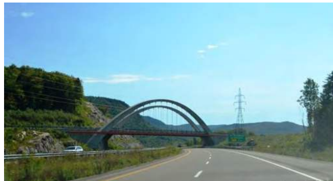
Le pont du boulevard Talbot marque le passage de la route 175 à Stoneham-et-Tewkesbury.
