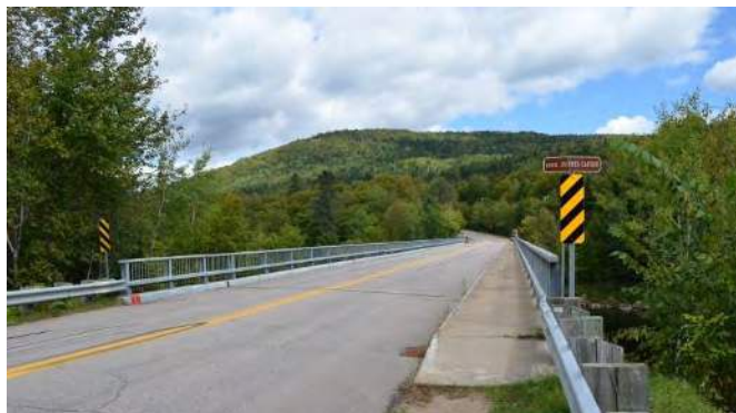
Le pont du chemin Redmond offre une vue sur les collines de Tewkesbury.
