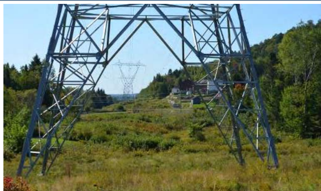
Depuis le chemin du Hibou, on aperçoit la ligne de transport d'énergie qui traverse l'unité.
