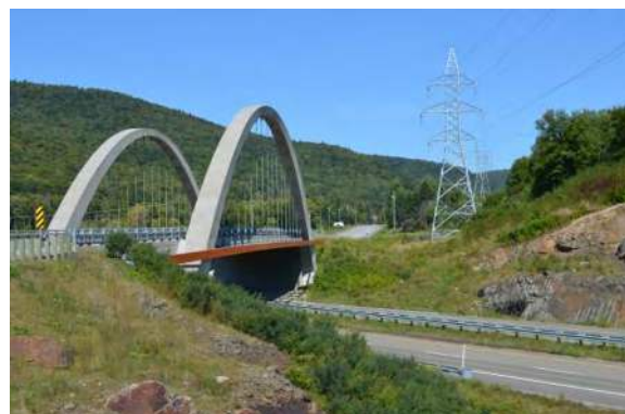
Le pont du boulevard Talbot marque le passage de la route 175 à Stoneham-et-Tewkesbury.
