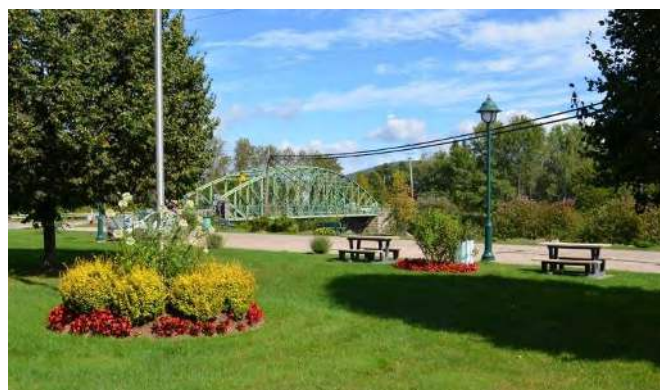
Le pont Clark de Saint-Gabriel-de-Valcartier est un pont Macquet à poutres paraboliques qui enjambe la rivière Jacques-Cartier. La construction de son actuelle structure de fer date de 1891. (Histoires oubliées, Les Productions Vic Pelletier Inc.)
