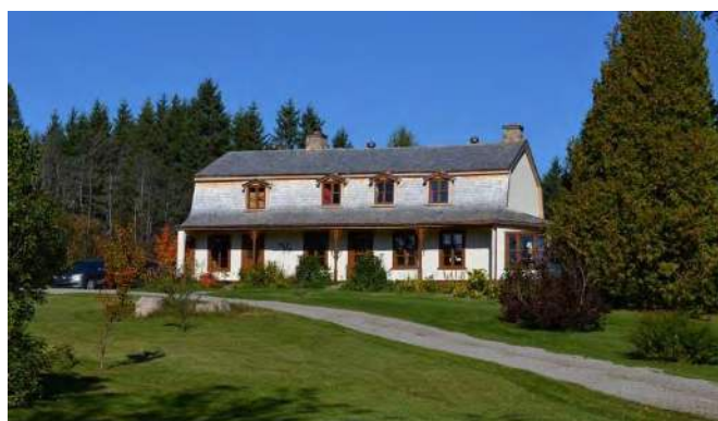
La maison Simons fait partie du patrimoine bâti de la municipalité de Lac-Beauport. La MRC lui attribue une valeur « supérieure ».
