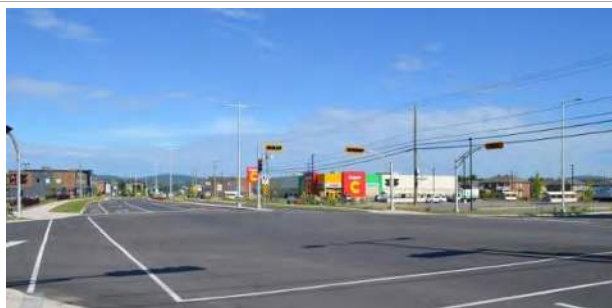
L'entrée de ville est marquée par des magasins de grande surface.
