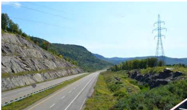
Vue sur la route 175 depuis le pont du boulevard Talbot.
