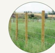
Clôture rustique. S'inspirant du langage à la fois matériel et formel des clôtures agricoles, la conception et l'installation de la clôture respectent les principes suivants : une hauteur maximale de 1 m. ; des poteaux espacés pour optimiser la « transparence ». Les matériaux utilisés sont des poteaux ronds en cèdre.
